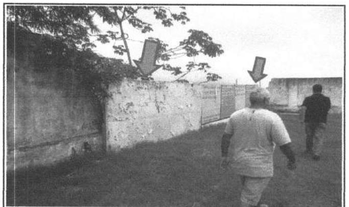
FOTO 24 - REPOSIÇÃO DE MURO CAÍDO E RACHADO
