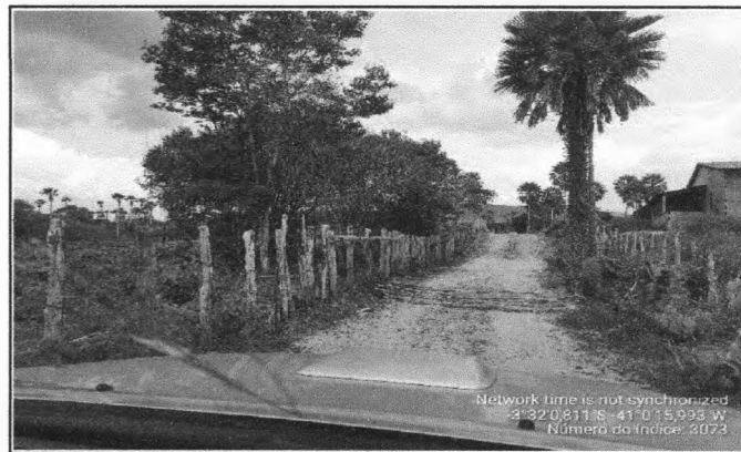
FOTO 2 LOCAL DA CONSTRUÇÃO-BUEIRO CAPEADO
