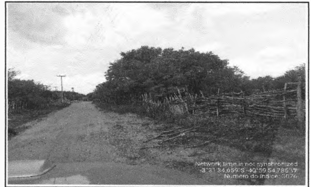
FOTO 2 - LOCAL DA CONSTRUÇÃO - BUEIRO
