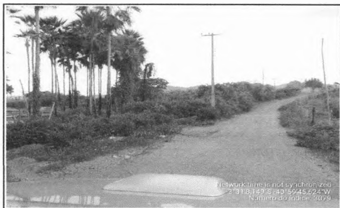
FOTO 1 - LOCAL DA CONSTRUÇÃO - BUEIRO
