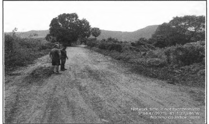
FOTO 2 - LOCAL DA CONSTRUÇÃO - BUEIRO
