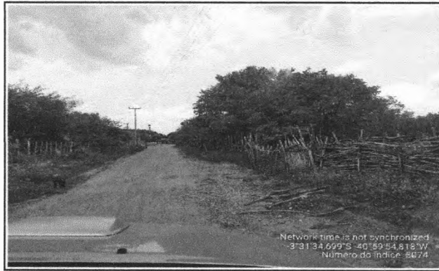
FOTO 1 - LOCAL DA CONSTRUÇÃO - BUEIRO
