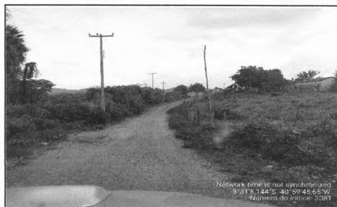
FOTO 2 - LOCAL DA CONSTRUÇÃO - BUEIRO
