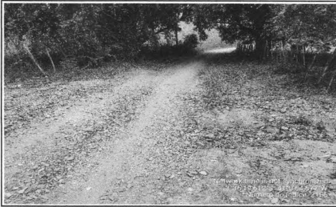
FOTO 1 - LOCAL DA CONSTRUÇÃO - BUEIRO CAPEADO
