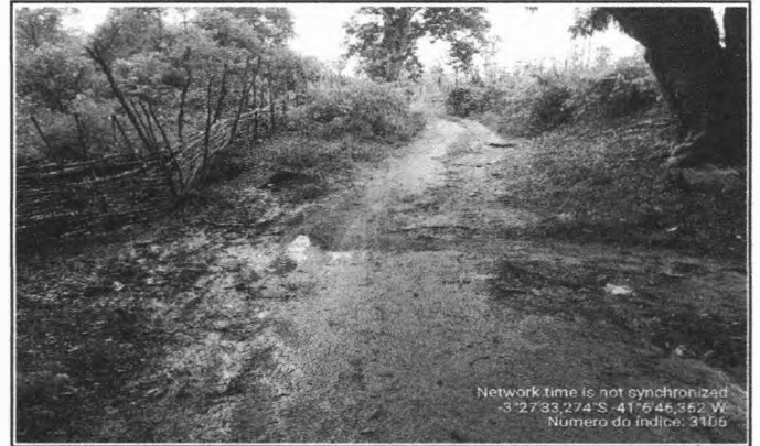
FOTO 2 - LOCAL DA CONSTRUÇÃO - BUEIRO CAPEADO
