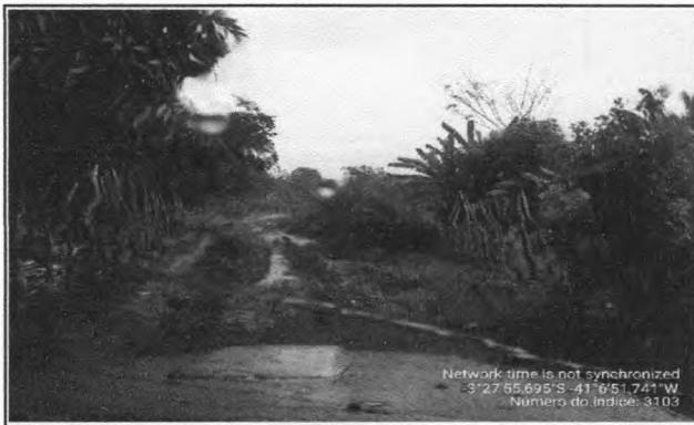
FOTO 1 - LOCAL DA CONSTRUÇÃO - BUEIRO
