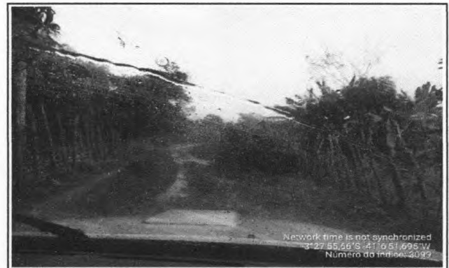
FOTO 2 - LOCAL DA CONSTRUÇÃO - BUEIRO
