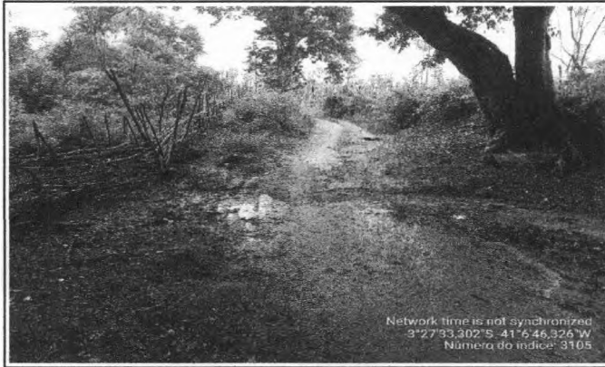
FOTO 1 - LOCAL DA CONSTRUÇÃO - BUEIRO CAPEADO
