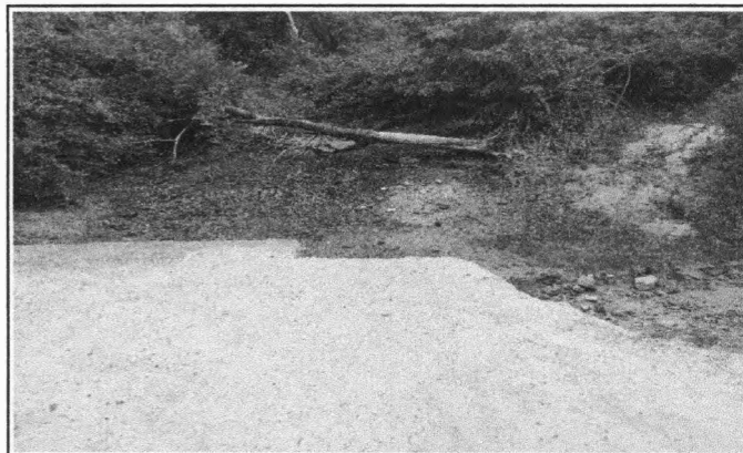
FOTO 2 - LOCAL DA CONSTRUÇÃO - A JUSANTE
