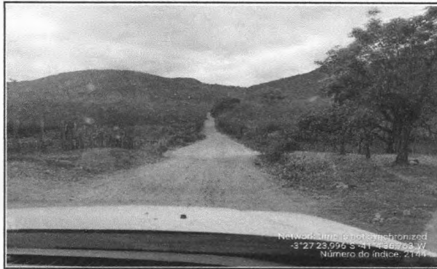
FOTO 1 LOCAL DA CONSTRUÇÃO-BUEIRO CAPEADO
