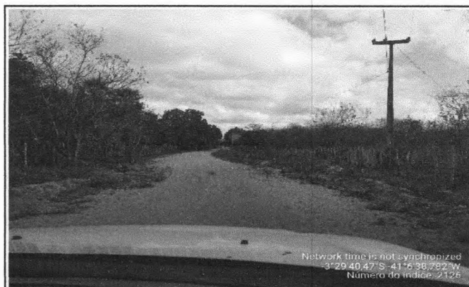
FOTO 2 - LOCAL DA CONSTRUÇÃO - BUEIRO TRIPLO TUBULAR
