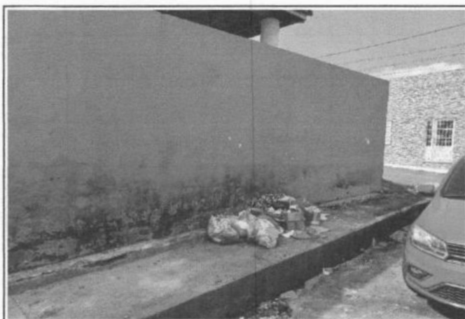
FOTO 23 - EXECUÇÃO DE DEPÓSITO PARA REJEITOS
