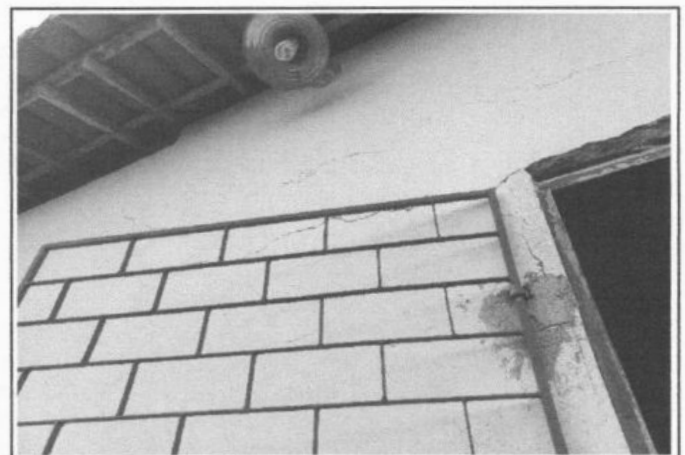
FOTO 24 - RACHADURAS ESTRUTURAIS
