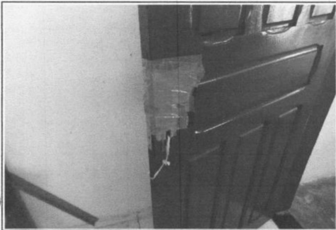
FOTO 15 - SUBSTITUIÇÃO DE PORTAS
