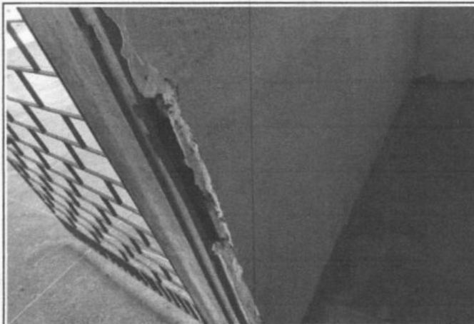
FOTO 21 - FORRAMENTOS DANIFICADOS
