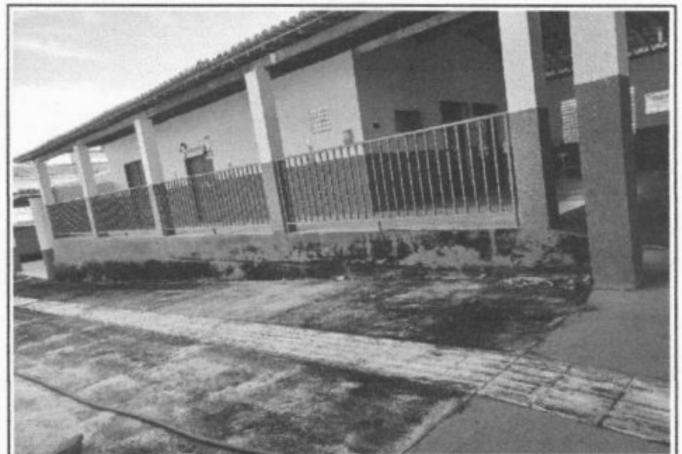
FOTO 2 - REVESTIMENTOS DETERIORADOS
