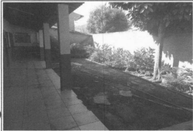
FOTO 9 - SUBSTITUIÇÃO DE PAVIMENTOS
