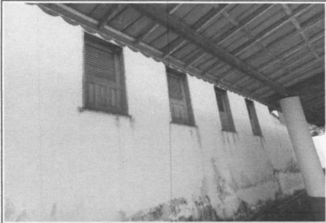
FOTO 7 - SUBSTITUIÇÃO DE ESQUADRIAS
