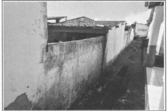
FOTO 8 - CONSTRUÇÃO DE MURO MAIS ALTO
