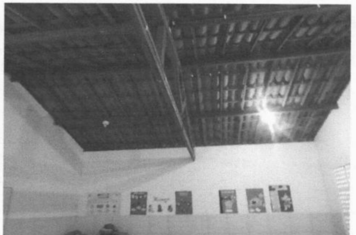
FOTO 12 - LÂMPADAS A SEREM SUBSTITUÍDAS
