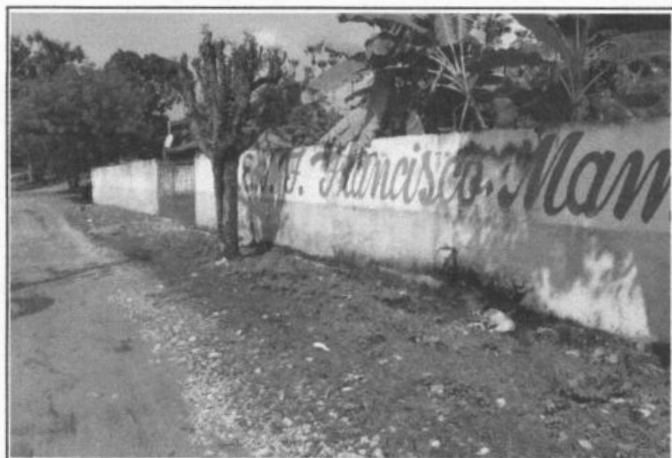
FOTO 1 - MURO DE CONTORNO FACHADA
