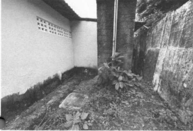
FOTO 7 - LOCAL DA ÁREA DE SERVIÇO A SER CONSTRUÍDA
