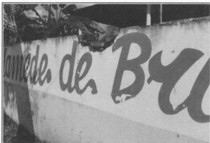
FOTO 4 - MURO DE CONTORNO FACHADA
