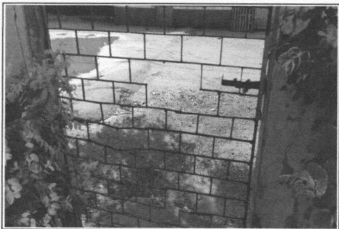
FOTO 5 - PORTÃO MURO DE CONTORNO ENTRADA
