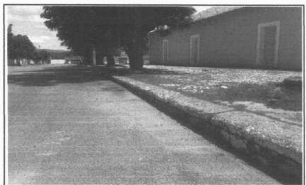
FOTO 18 - MEIO - FIO EXISTENTE
