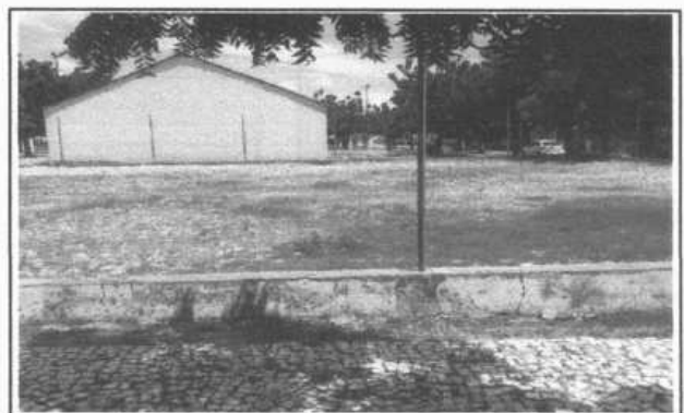
FOTO 24 - VISTA POSTERIOR IGREJA EXISTENTE
