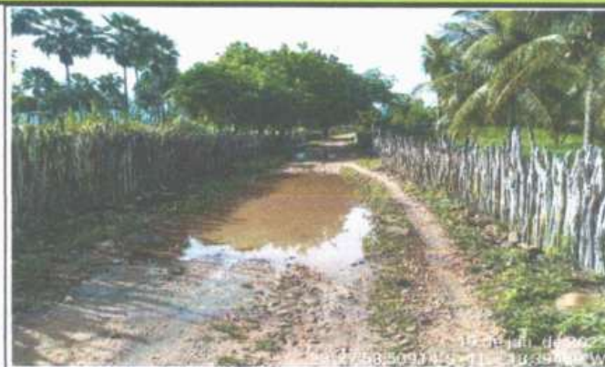
FOTO 8 - LOCAL DA CONSTRUÇÃO - BUEIRO
