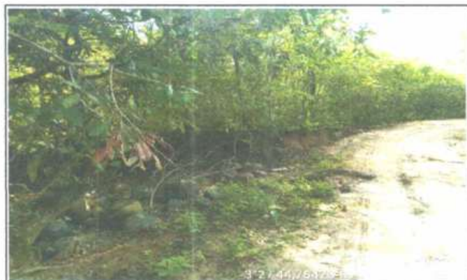
FOTO 5 - LOCAL DA CONSTRUÇÃO - BUEIRO TRIPLO TUBULAR
