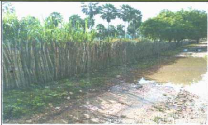
FOTO 7 - LOCAL DA CONSTRUÇÃO - BUEIRO SIMPLES TUBULAR
