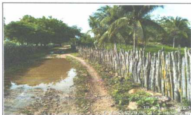
FOTO 6 - LOCAL DA CONSTRUÇÃO - BUEIRO SIMPLES TUBULAR
