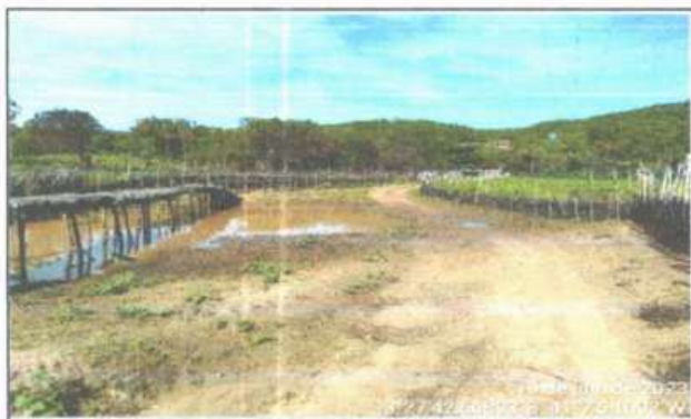
FOTO 1 - LOCAL DA CONSTRUÇÃO - BUEIRO
