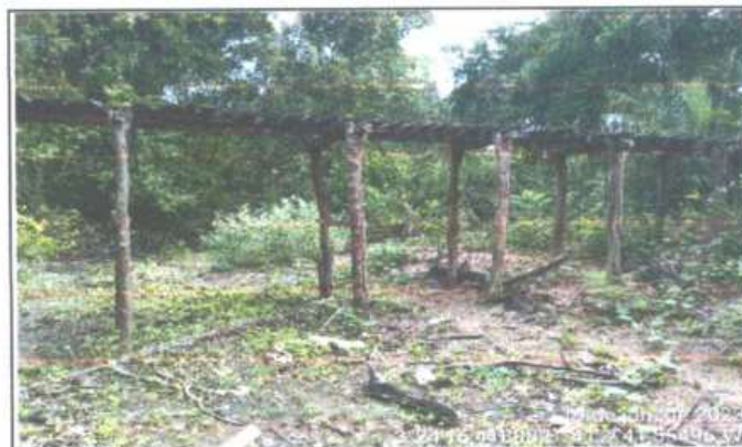
FOTO 2 - LOCAL DA CONSTRUÇÃO - TRAVESSIA DE MADEIRA EXISTENTE
