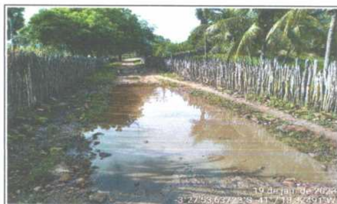
FOTO 4 - LOCAL DA CONSTRUÇÃO - BUEIRO SIMPLES TUBULAR
