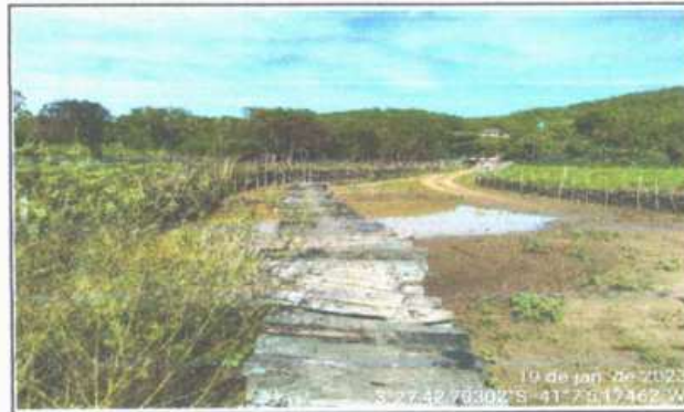
FOTO 8 - LOCAL DA CONSTRUÇÃO - BUEIRO CAPEADO
