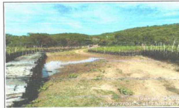
FOTO 10 - LOCAL DA CONSTRUÇÃO - BUEIRO CAPEADO
