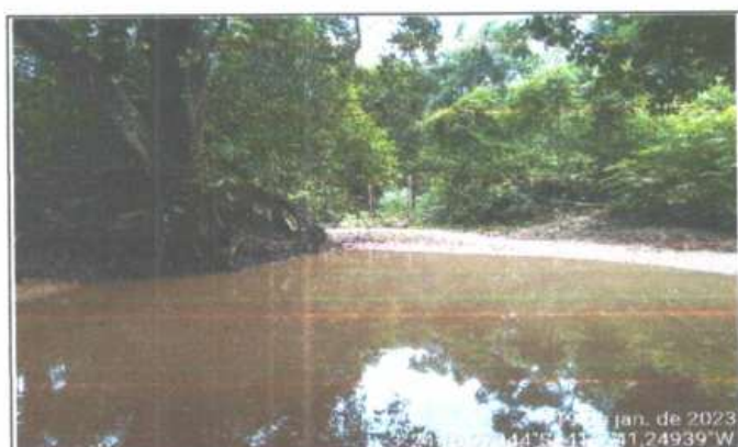
FOTO 5 - À JUSANTE - BUEIRO
