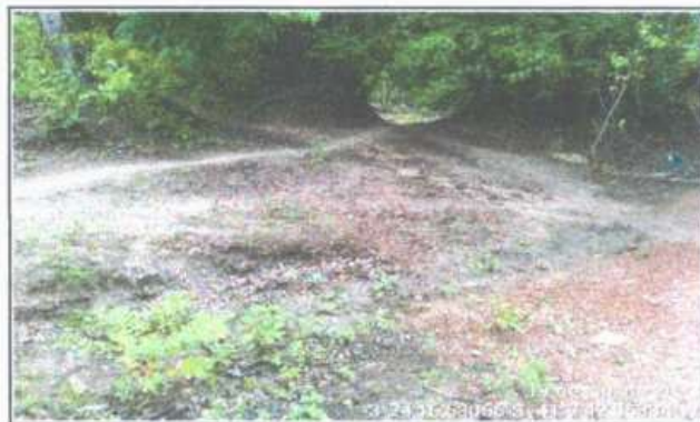
FOTO 2 - LOCAL DA CONSTRUÇÃO - BUEIRO SIMPLES TUBULAR
