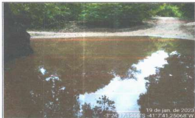
FOTO 7 - À MONTANTE - BUEIRO
