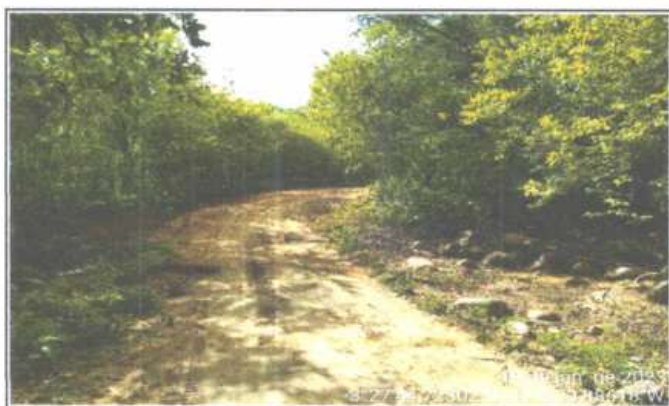
FOTO 1 - LOCAL DA CONSTRUÇÃO - BUEIRO TRIPLO TUBULAR
