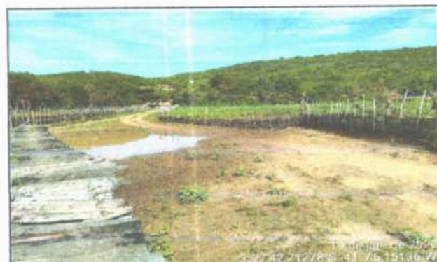
FOTO 9 - LOCAL DA CONSTRUÇÃO - BUEIRO CAPEADO
