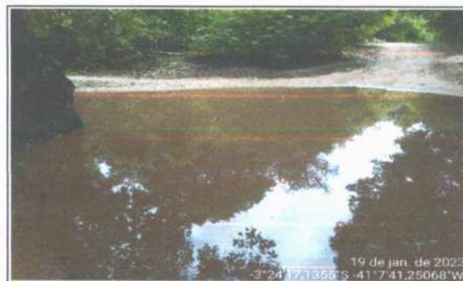
FOTO 8 - À MONTANTE - BUEIRO
