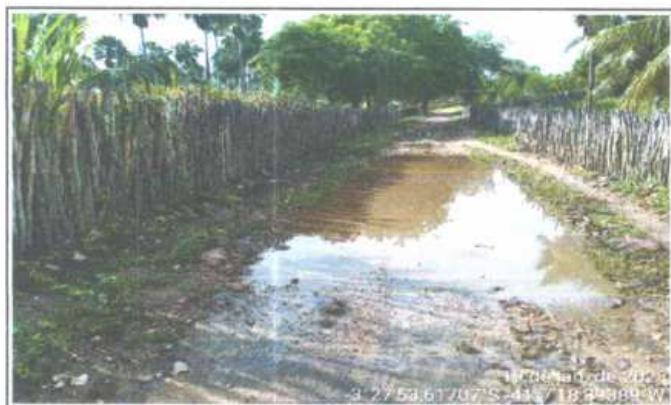
FOTO 3 - LOCAL DA CONSTRUÇÃO - BUEIRO SIMPLES TUBULAR
