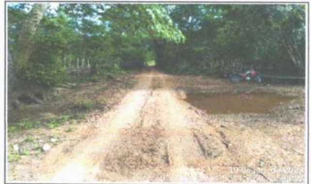
FOTO 2 - LOCAL DA CONSTRUÇÃO - BUEIRO TRIPLO
