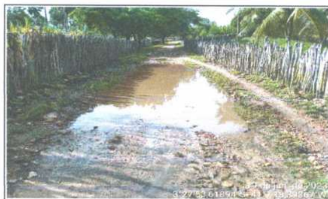
FOTO 2 - LOCAL DA CONSTRUÇÃO - BUEIRO SIMPLES TUBULAR
