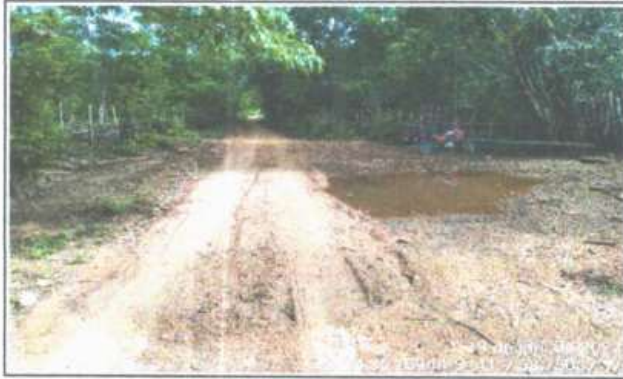
FOTO 1 - LOCAL DA CONSTRUÇÃO - BUEIRO TRIPLO TUBULAR
