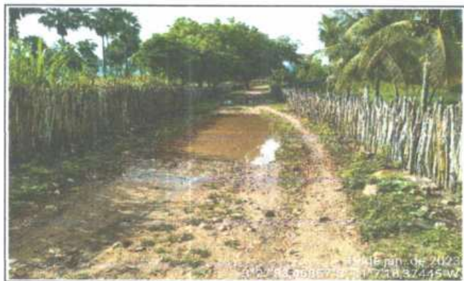
FOTO 1 - LOCAL DA CONSTRUÇÃO - BUEIRO SIMPLES TUBULAR
