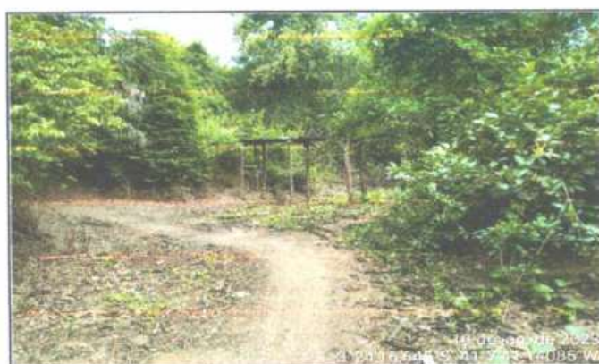
FOTO 6 - LOCAL DA CONSTRUÇÃO - BUEIRO CAPEADO
