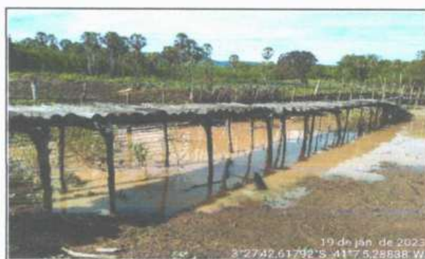
FOTO 6 - TRAVESSIA EXISTENTE DE MADEIRA
