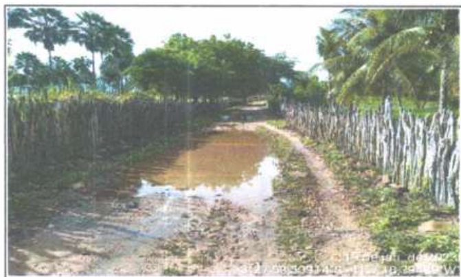
FOTO 5 - LOCAL DA CONSTRUÇÃO - BUEIRO SIMPLES TUBULAR
