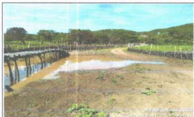
FOTO 3 - LOCAL DA CONSTRUÇÃO - BUEIRO CAPEADO
