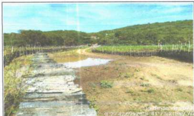
FOTO 7 - LOCAL DA CONSTRUÇÃO - BUEIRO CAPEADO
