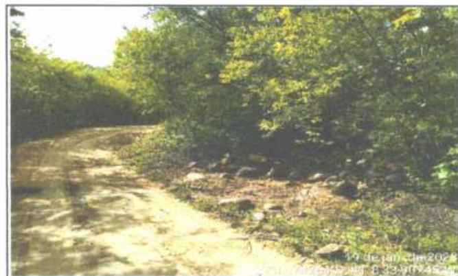
FOTO 6 - LOCAL DA CONSTRUÇÃO - BUEIRO TRIPLO TUBULAR
