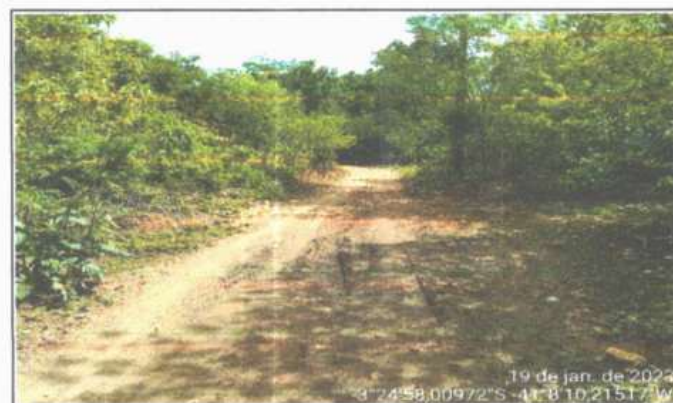
FOTO 5 LOCAL DA CONSTRUÇÃO - BUEIRO CAPEADO
