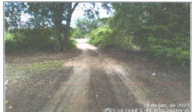
FOTO 4 - LOCAL DA CONSTRUÇÃO - BUEIRO TRIPLO
