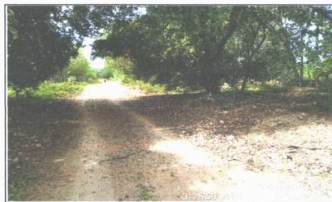
FOTO 6 - À JUSANTE - BUEIRO SIMPLES TUBULAR
