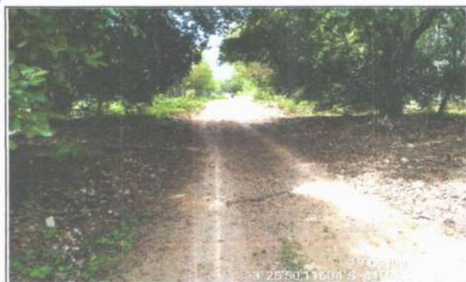
FOTO 5 - À JUSANTE - BUEIRO SIMPLES TUBULAR
