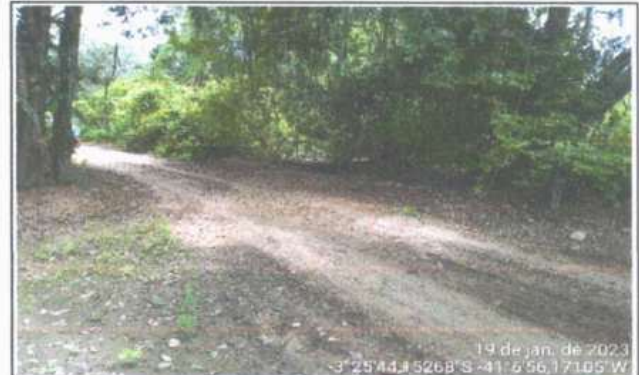
FOTO 2 - À MONTANTE - BUEIRO TRIPLO
