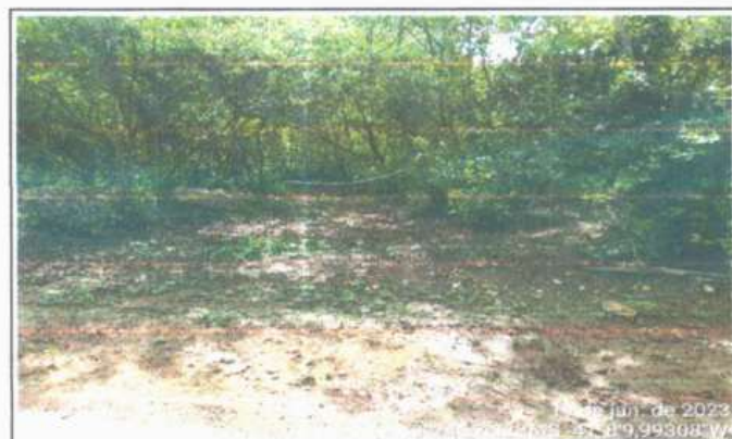
FOTO 3 À JUSANTE - BUEIRO
