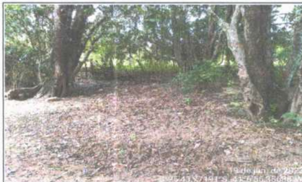
FOTO 3 - À JUSANTE - BUEIRO TRIPLO
