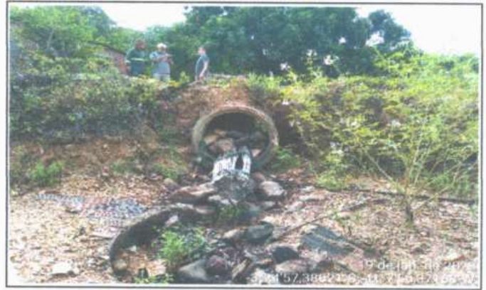
FOTO 2 LOCAL DA CONSTRUÇÃO-BUEIRO EXISTENTE
