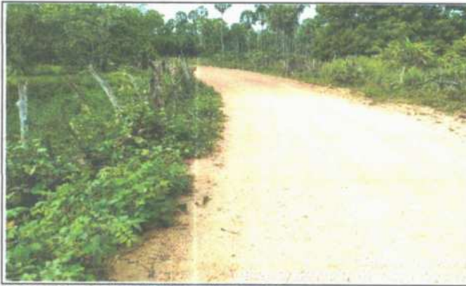
FOTO 1 LOCAL DA CONSTRUÇÃO-BUEIRO CAPEADO
