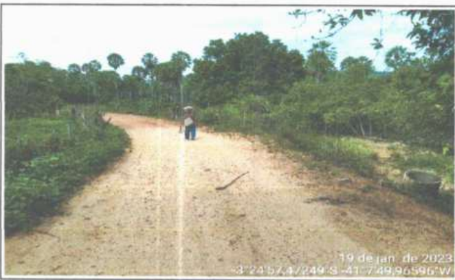
FOTO 5 LOCAL DA CONSTRUÇÃO - BUEIRO CAPEADO
