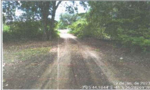
FOTO 1 - LOCAL DA CONSTRUÇÃO - BUEIRO TRIPLO TUBULAR
