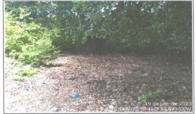
FOTO 8 - À MONTANTE - BUEIRO
