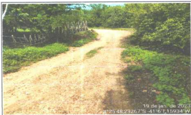
FOTO 1 - LOCAL DA CONSTRUÇÃO - BUEIRO
