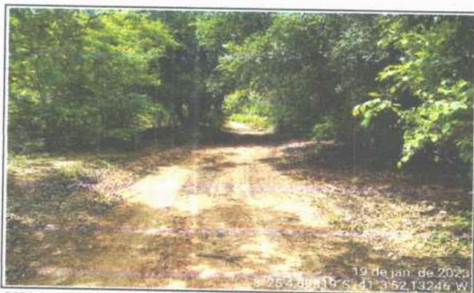
FOTO 1 - LOCAL DA CONSTRUÇÃO - BUEIRO SIMPLES TUBULAR
