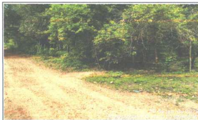
FOTO 6 - LOCAL DA CONSTRUÇÃO - BUEIRO SIMPLES TUBULAR
