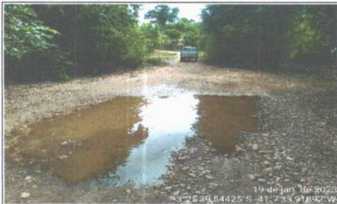
FOTO 3 - LOCAL DA CONSTRUÇÃO - BUEIRO RETANGULAR
