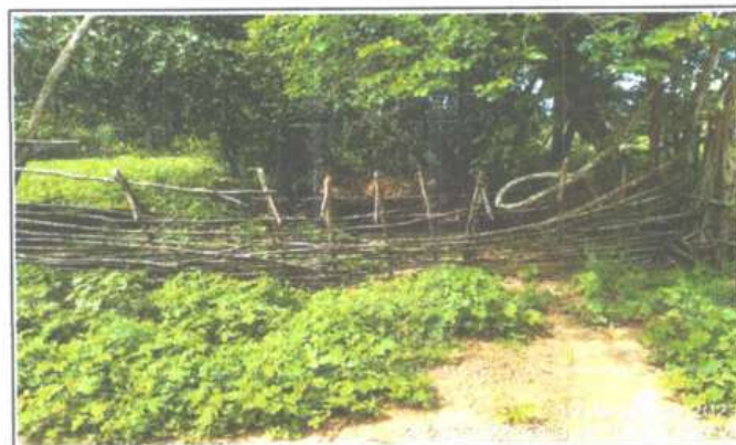
FOTO 3 - À MONTANTE - BUEIRO
