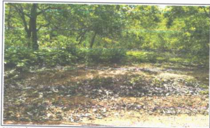
FOTO 5 - À MONTANTE - BUEIRO SIMPLES TUBULAR
