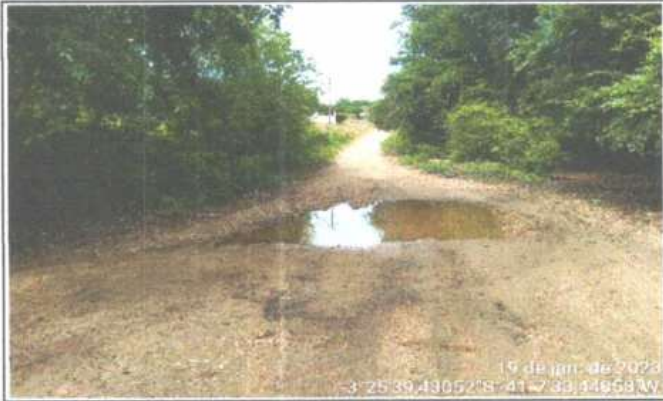
FOTO 7 - LOCAL DA CONSTRUÇÃO - BUEIRO RETANGULAR
