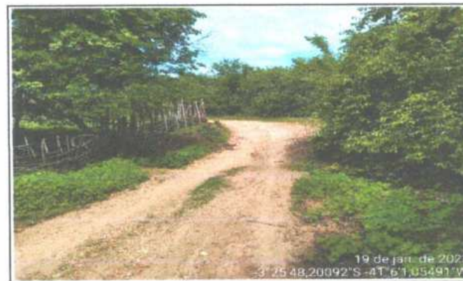
FOTO 6 - LOCAL DA CONSTRUÇÃO-BUEIRO
