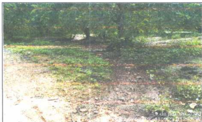
FOTO 3 - À MONTANTE - BUEIRO SIMPLES TUBULAR
