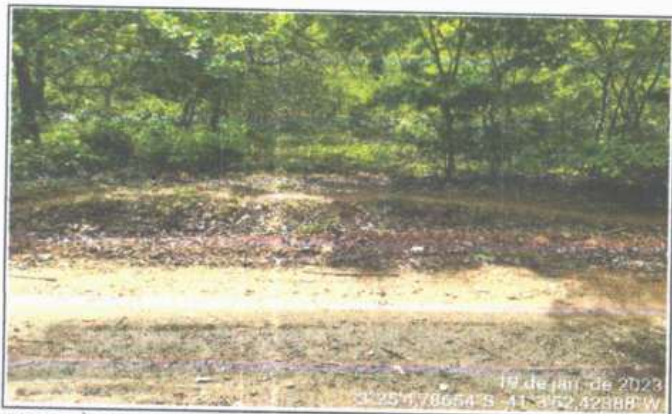
FOTO 3 - À MONTANTE - BUEIRO SIMPLES TUBULAR
