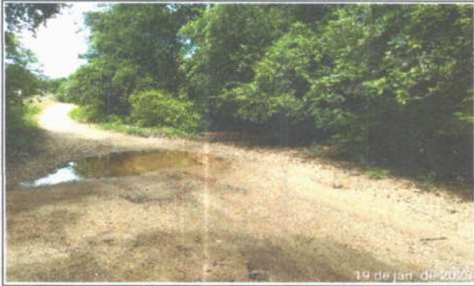
FOTO 1 - LOCAL DA CONSTRUÇÃO - BUEIRO RETANGULAR
