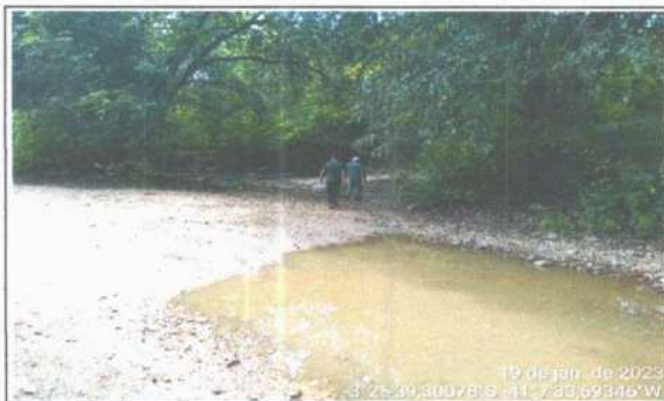
FOTO 5 - À JUSANTE - BUEIRO
