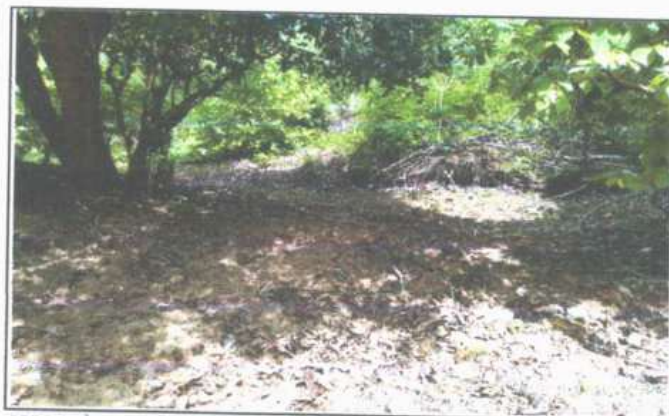
FOTO 4 - À JUSANTE - BUEIRO SIMPLES TUBULAR
