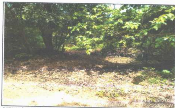
FOTO 2 - À JUSANTE - BUEIRO SIMPLES TUBULAR
