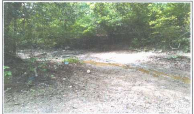
FOTO 2 - À JUSANTE - BUEIRO RETANGULAR
