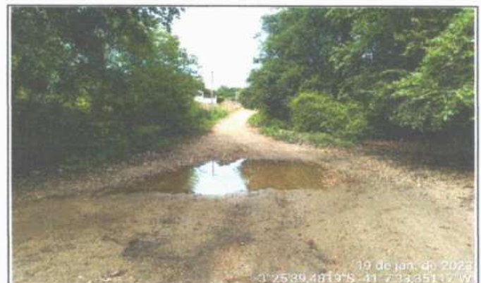
FOTO 6 - LOCAL DA CONSTRUÇÃO - BUEIRO RETANGULAR
