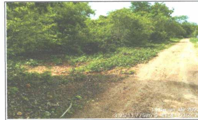
FOTO 6 - LOCAL DA CONSTRUÇÃO-BUEIRO
