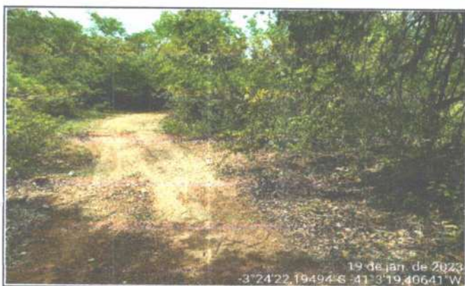
FOTO 1 - LOCAL DA CONSTRUÇÃO - BUEIRO SIMPLES TUBULAR
