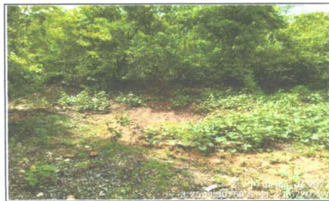
FOTO 2 - À JUSANTE - BUEIRO
