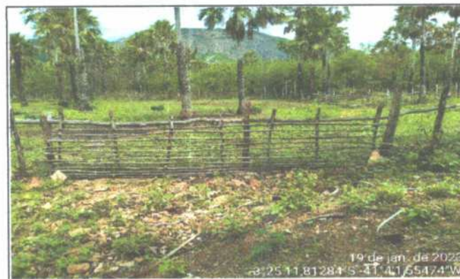
FOTO 5 - À JUSANTE - BUEIRO
