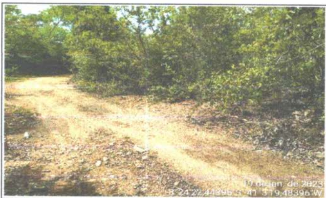
FOTO 3 - À JUSANTE - BUEIRO SIMPLES TUBULAR
