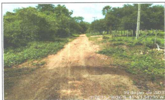
FOTO 1 - LOCAL DA CONSTRUÇÃO - BUEIRO
