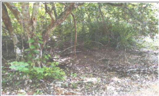
FOTO 5 - À MONTANTE - BUEIRO SIMPLES TUBULAR
