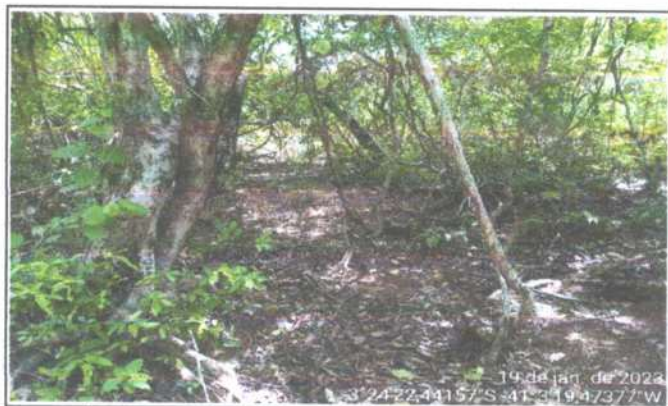
FOTO 2 - À MONTANTE - BUEIRO SIMPLES TUBULAR
