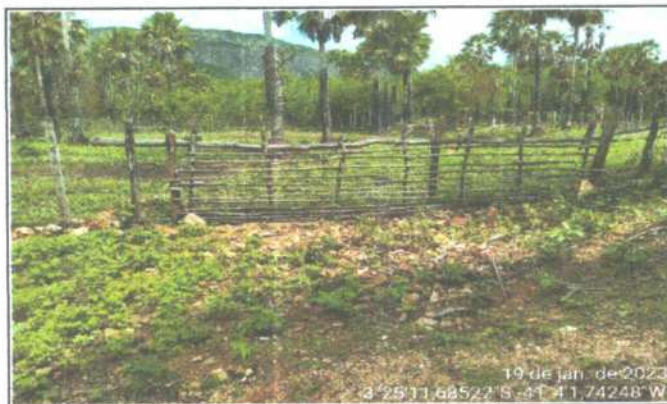
FOTO 3 - À MONTANTE - BUEIRO
