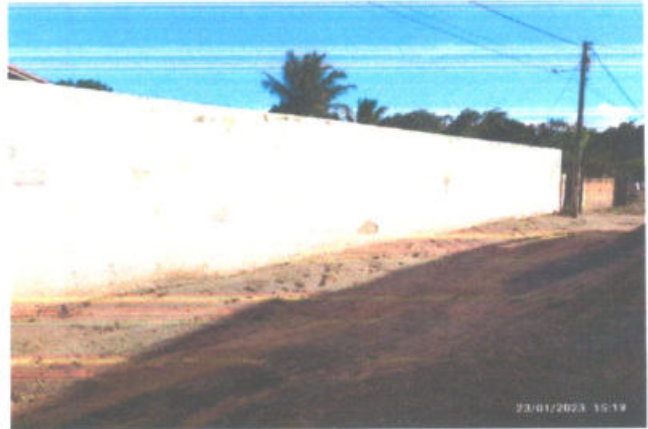
FOTO 2 - MURO EXTERNO LATERAL DIREITA DO PRÉDIO
