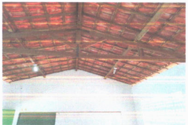
FOTO 10 - REPAROS E TROCAS DA INSTALAÇÃO ELÉTRICA
