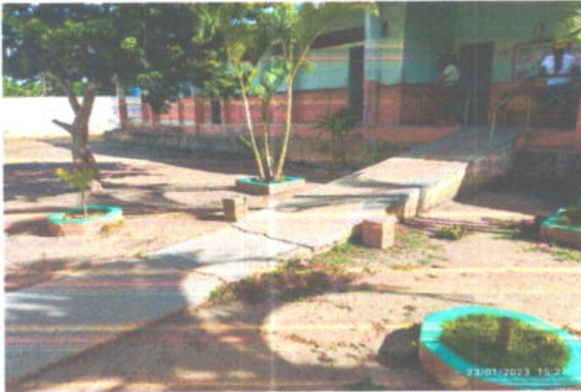
FOTO 1 - RAMPA DE ACESSO
