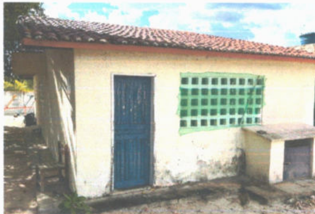
FOTO 2 - REPAROS EM PINTURAS
