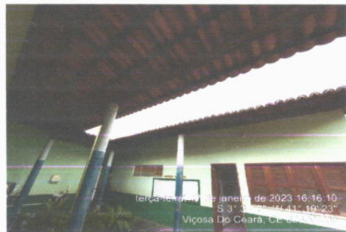
FOTO 10 - NECESSIDADE DE AMPLIAR A COBERTURA DO PÁTIO
