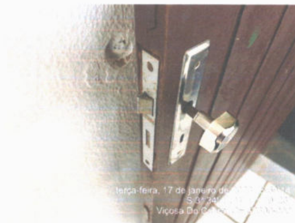
FOTO 4 - FECHADURAS DANIFICADAS
