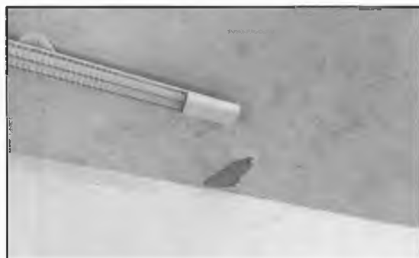
FOTO 28 - RECUPERAÇÃO PINTURA LAJE DE FÔRRO
