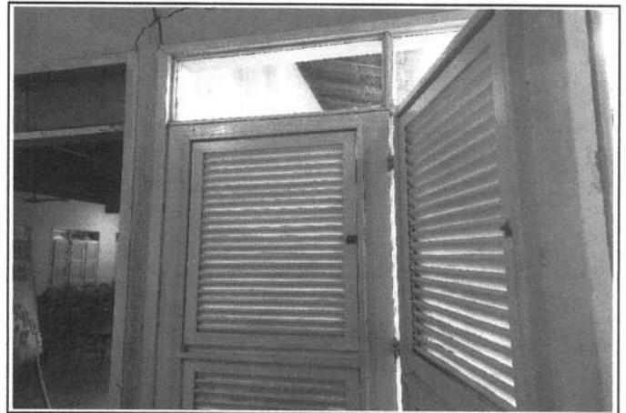
FOTO 2 - SUBSTITUIÇÃO DE ESQUADRIAS
