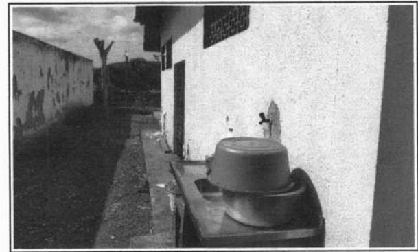
FOTO 18 - RECUPERAÇÃO DE PINTURA EXTERNA
