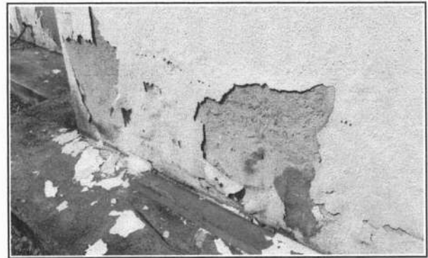
FOTO 16 - RECUPERAÇÃO DE PINTURA EXTERNA
