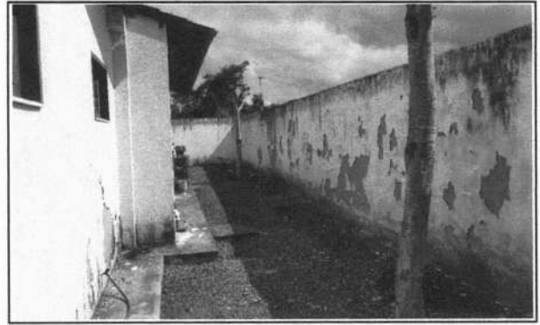
FOTO 14 - RECUPERAÇÃO REBOCO DETERIORADO MURO DE CONTORNO
