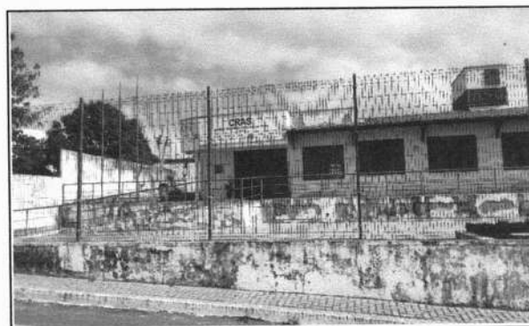
FOTO 4 - RECUPERAÇÃO PINTURA MURETAS
