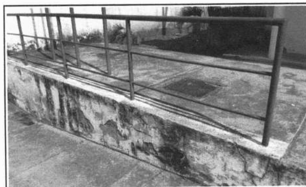
FOTO 8 - RECUPERAÇÃO REBOCO DETERIORADO MURETA
