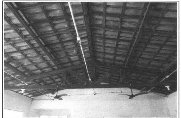
FOTO 8 - DESCUPINIZAÇÃO E PINTURA EM MADEIRAMENTO
