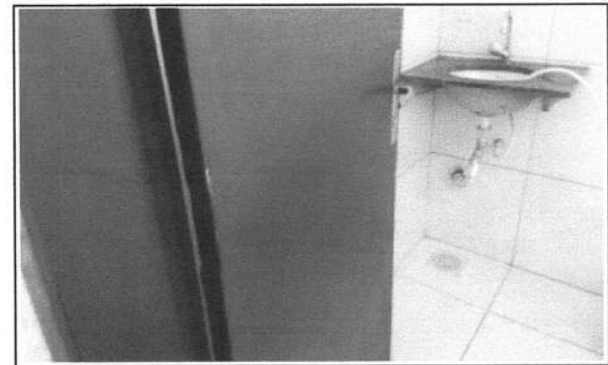
FOTO 36 - SUBSTITUIÇÃO DE PORTA W.C. FUNCIONÁRIO FEMININO
