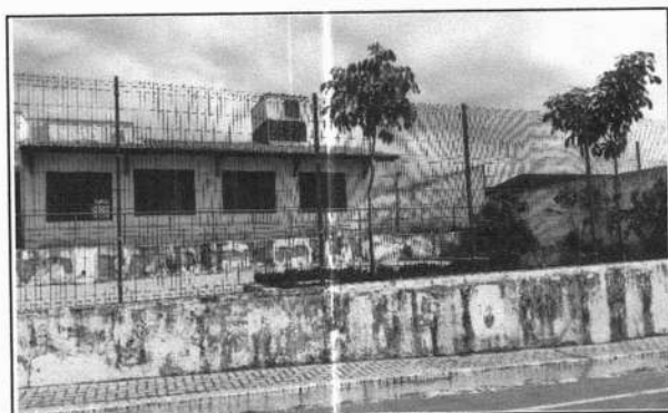
FOTO 5 - RETIRADA DE VAZAMENTO CAIXA D'ÁGUA
