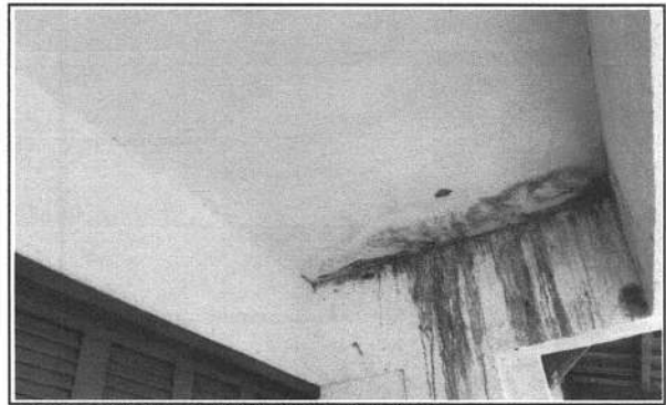
FOTO 50 - RECUPERAÇÃO INFILTRAÇÃO LAJE DE FÔRRO
