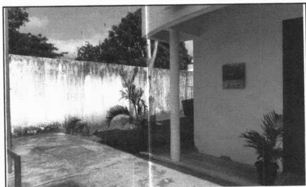
FOTO 9 - RECUPERAÇÃO PINTURA MURO DE CONTORNO
