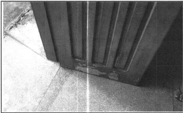
FOTO 49 - RECUPERAÇÃO PINTURA ESQUADRIAS
