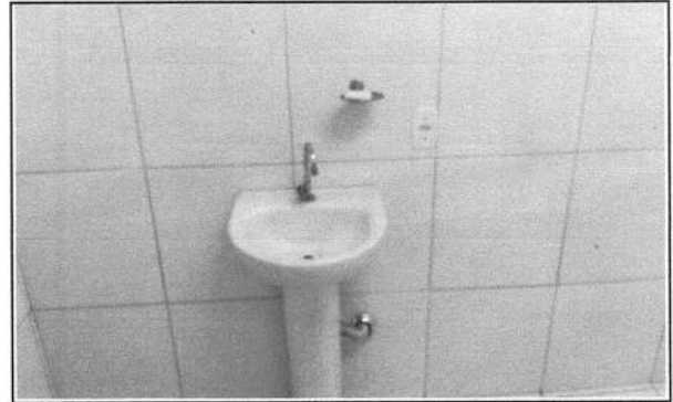
FOTO 32 - SUBSTITUIÇÃO DE TORNEIRA LAVATÓRIO W.C. FEMININO
