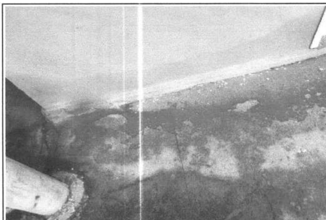
FOTO 11 - PINTURA SOBRE PISO
