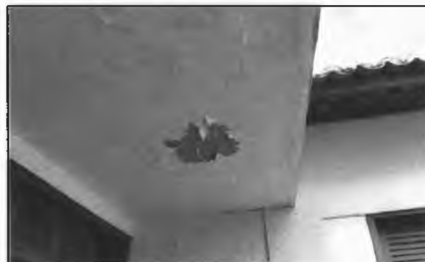
FOTO 30 - RECUPERAÇÃO INFILTRAÇÃO MARQUISE
