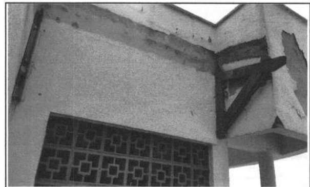
FOTO 58 - RECUPERAÇÃO COBERTA COLAPSADA
