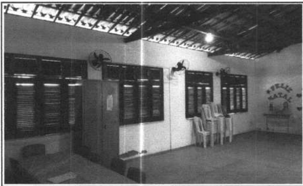
FOTO 59 - RECUPERAÇÃO PINTURA INTERNA SALA MULTIUSO
