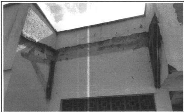
FOTO 51 - RECUPERAÇÃO DE COBERTA COLAPSADA
