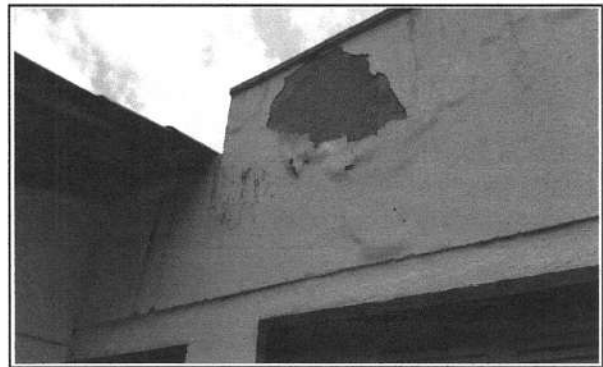
FOTO 54 - RECUPERAÇÃO DE PINTURA EXTERNA
