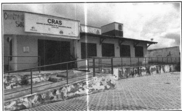
FOTO 7 - RECUPERAÇÃO PINTURA GUARDA-CORPO
