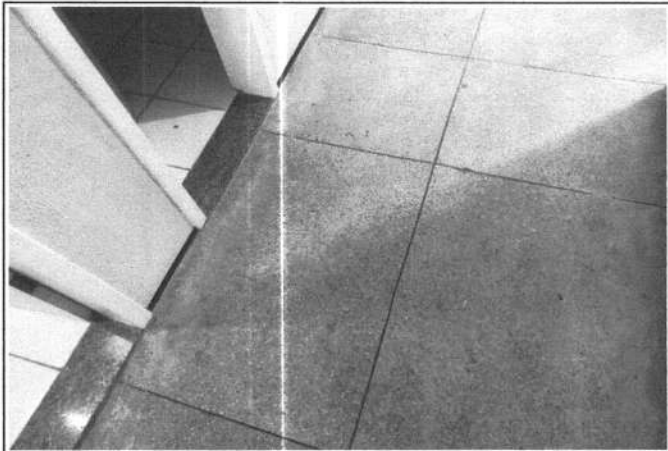
FOTO 7 - POLIMENTO DE PISO INDUSTRIAL
