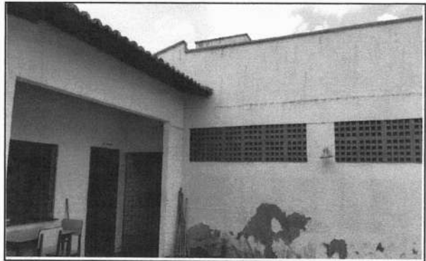
FOTO 20 - RECUPERAÇÃO DE PINTURA EXTERNA
