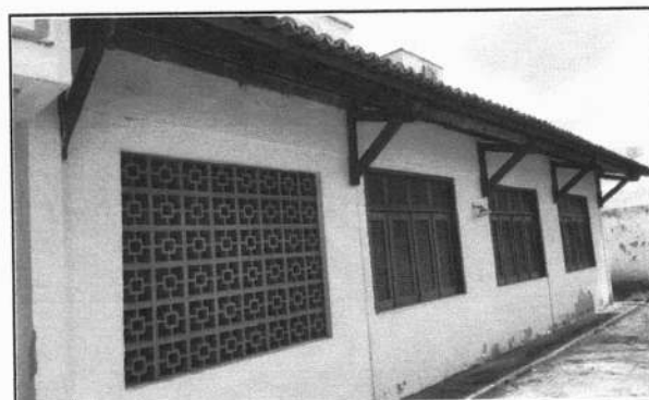
FOTO 10 - RECUPERAÇÃO DE PINTURA EXTERNA
