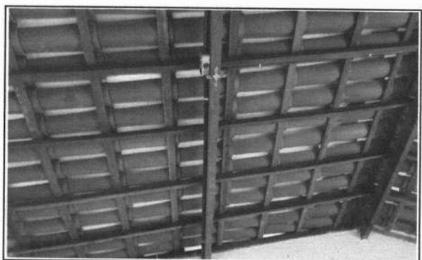
FOTO 24 - RECUPERAÇÃO DE LUMINÁRIA
