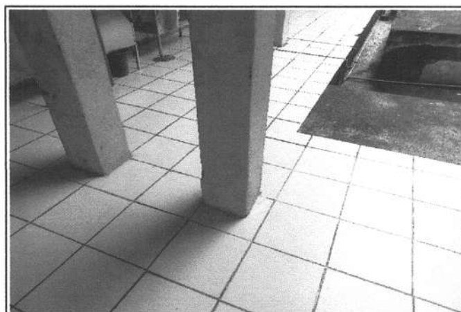
FOTO 4 - SUBSTITUIÇÃO DE PISOS
