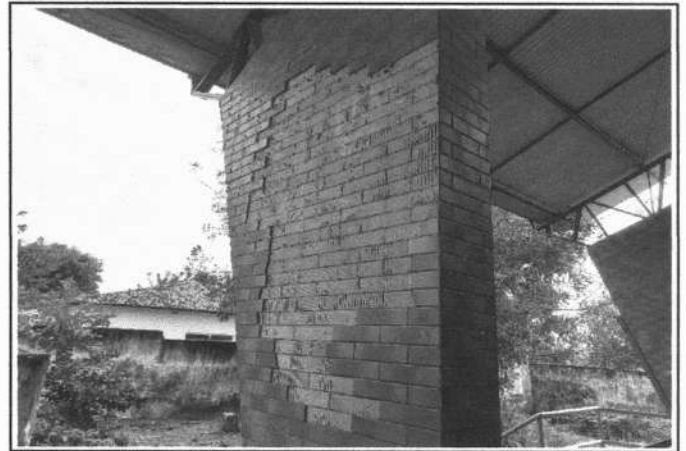
FOTO 22 - DEMOLIÇÃO DE REVESTIMENTOS
