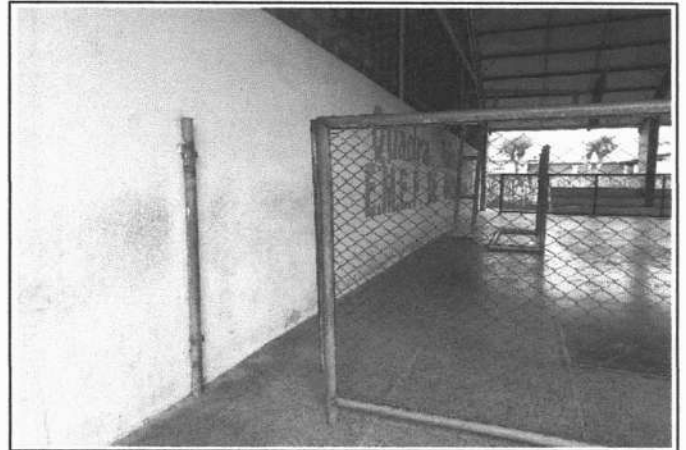
FOTO 20 - REPARO EM ALAMBRADOS
