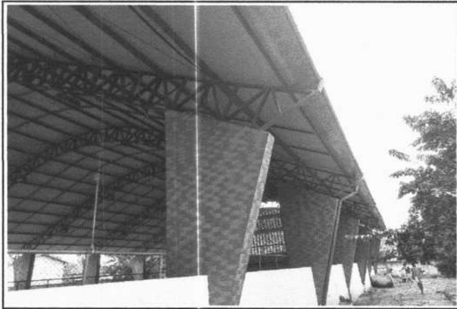
FOTO 21 - PINTURA EM ESTRUTURA METÁLICA
