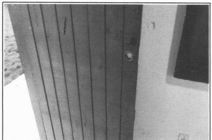
FOTO 18 - SUBSTITUIÇÃO DE ESQUADRIAS
