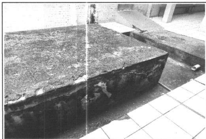
FOTO 5 - CISTERNA À DEMOLIR
