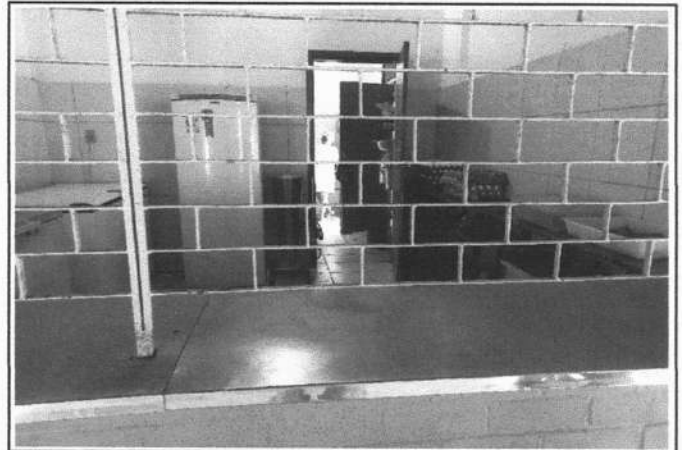
FOTO 14 - PINTURA EM ESQUADRIAS METÁLICAS
