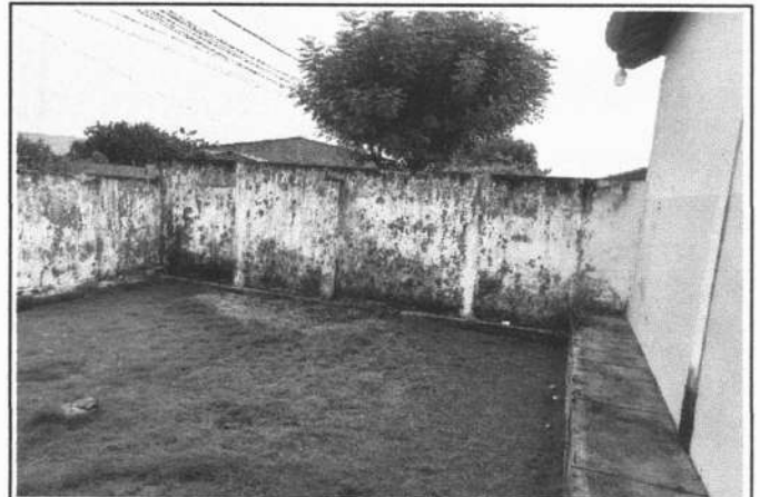
FOTO 8 - MUROS DE CONTORNO
