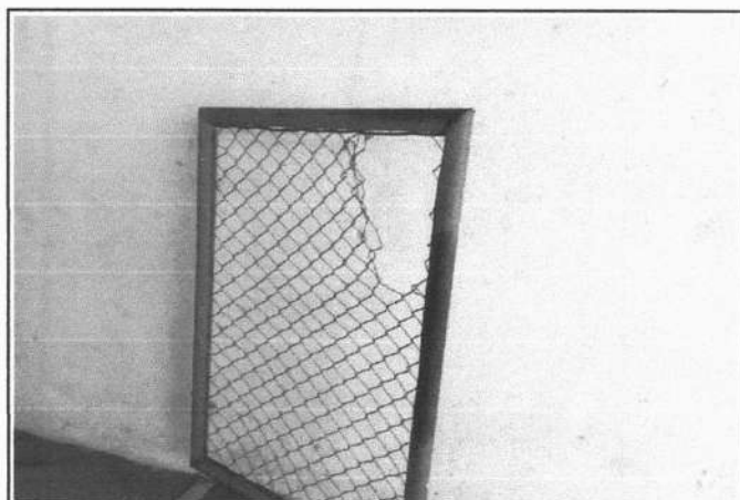
FOTO 8 - RECUPERAÇÃO E PINTURA DE ALAMBRADOS
