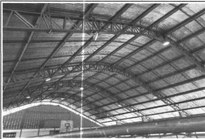
FOTO 5 - PROTEÇÃO E PINTURA DE ESTRUTURA
