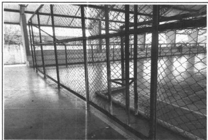
FOTO 11 - RECUPERAÇÃO DE ALAMBRADOS
