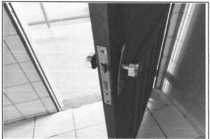
FOTO 6 - RECUPERAÇÃO DE ESQUADRIAS
