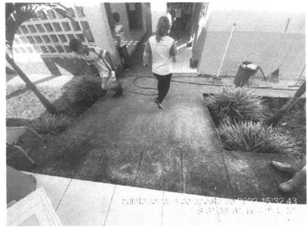
FOTO 4 - CORRIMÃO A SER INSTALADO
