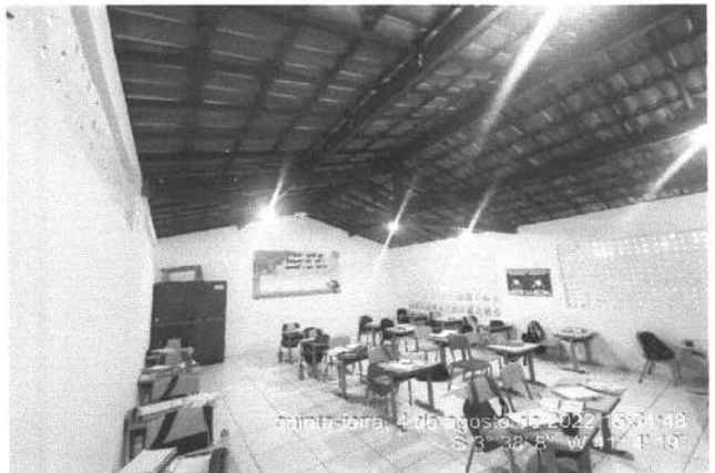
FOTO 6 - REV. CERÂMICO A SER EXECUTADO NAS SALAS
