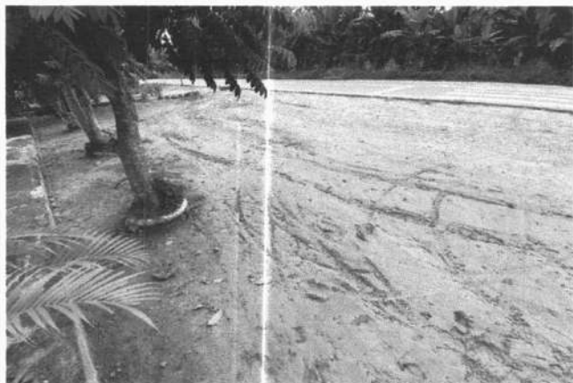
FOTO 13 - PISO DO ACESSO PRINCIPAL A PAVIMENTAR
