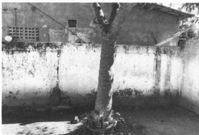
FOTO 14 - DEPÓSITO DE RESÍDUOS A SER CONSTRUÍDO
