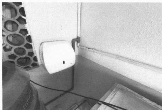
FOTO 10 - TUBULAÇÕES HIDRÁULICAS A SEREM EMBUTIDAS
