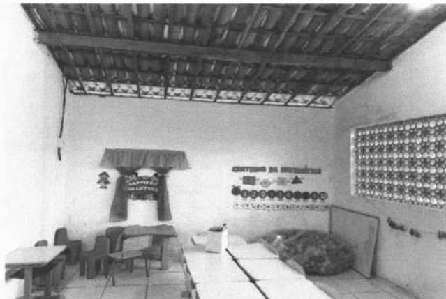
FOTO 8 - SALA DE AULA A RECEBER FORRO EM PVC
