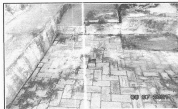
FOTO 5 - RECUPERAÇÃO DE PISO INTERTRAVADO
