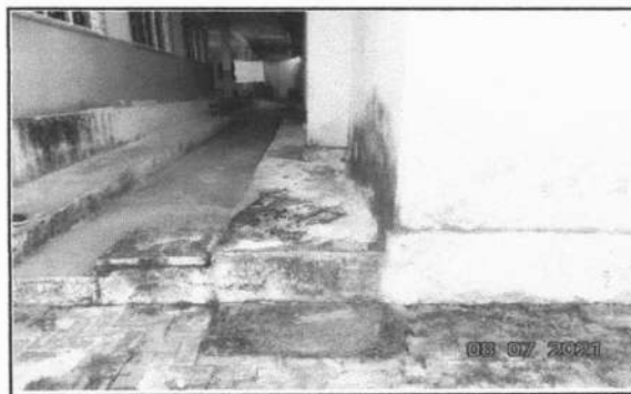
FOTO 2 - RECUPERAÇÃO DE CALÇADA DE CONTORNO
