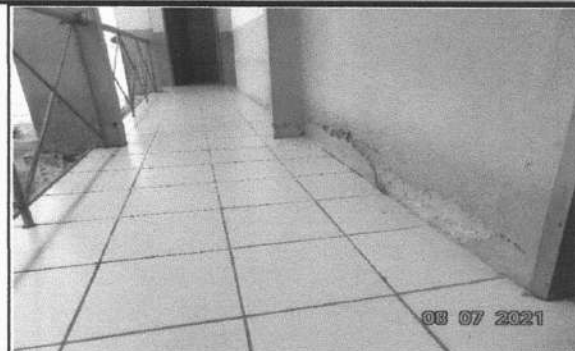
FOTO 20 - RECUPERAÇÃO DE REBOCO DETERIORADO
