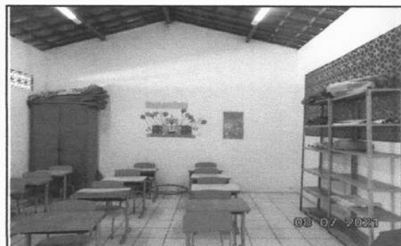
FOTO 24 - RECUPERAÇÃO DE PINTURA INTERNA
