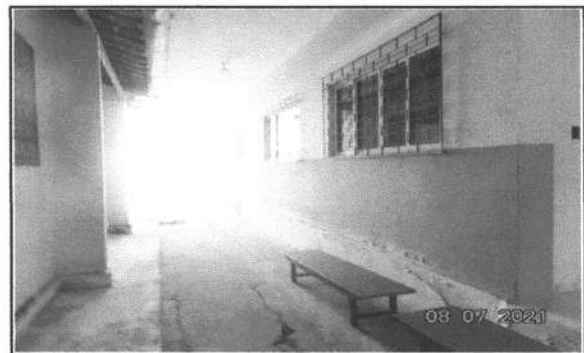
FOTO 10 - RECUPERAÇÃO DE PISO CIMENTADO
