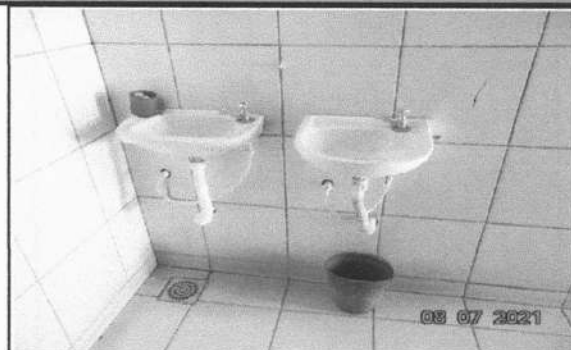
FOTO 14 - SUBSTITUIÇÃO DE SIFÃO E LAVATÓRIOS
