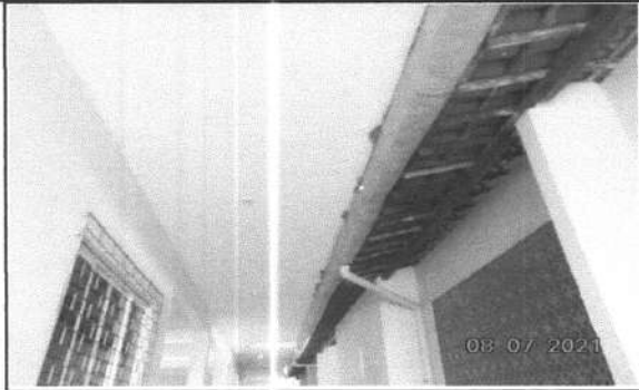
FOTO 7 - RECUPERAÇÃO DE CALHAS
