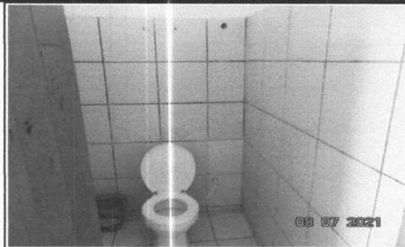
FOTO 19 - SUBSTITUIÇÃO DE BACIA SANITÁRIA COM CAIXA ACOPLADA
