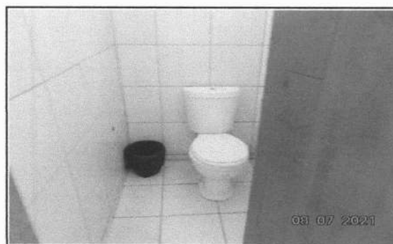
FOTO 18 - SUBSTITUIÇÃO DE BACIA SANITÁRIA COM CX. ACOPLADA
