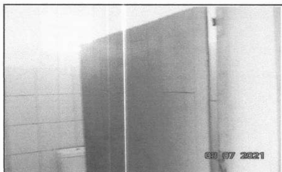
FOTO 17 - SUBSTITUIÇÃO DE PORTAS DANIFICADAS W.C.'S.
