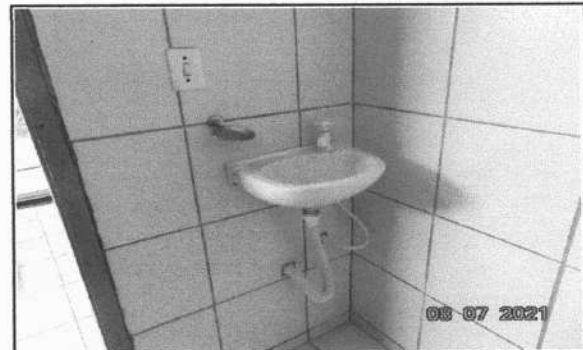
FOTO 28 - SUBSTITUIÇÃO DE INTERRUPTOR E SIFÃO W.C. P.N.E.
