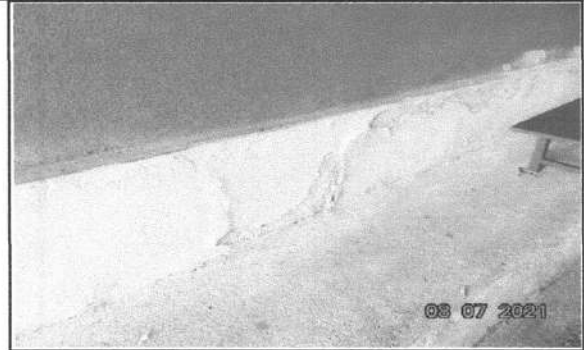
FOTO 8 - RECUPERAÇÃO DE ACABAMENTO EXTERNO
