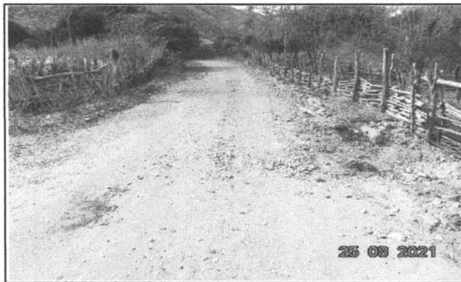
FOTO 3 - LOCAL DA CONSTRUÇÃO- BUEIRO
