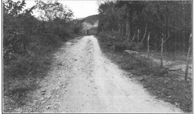
FOTO 8 - LOCAL DA CONSTRUÇÃO - BUEIRO
