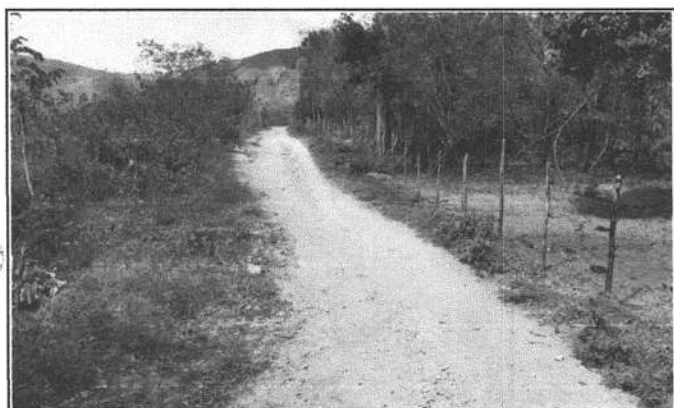
FOTO 1 - LOCAL DA CONSTRUÇÃO - BUEIRO
