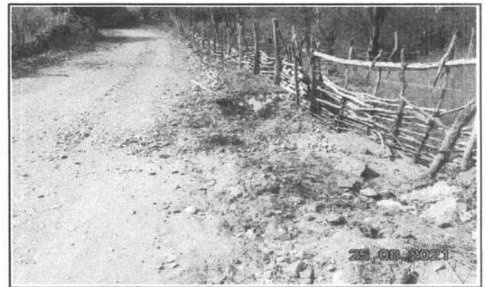
FOTO 4 - LOCAL DA CONSTRUÇÃO-BUEIRO
