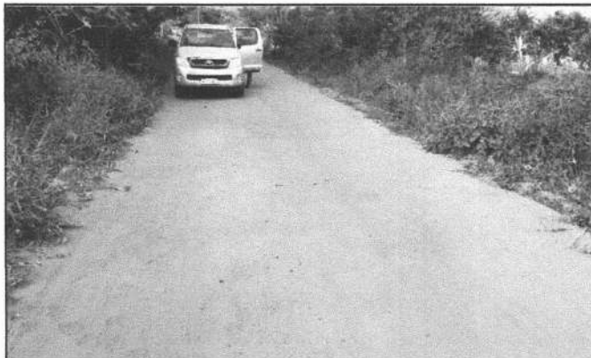
FOTO 3 - LOCAL DA CONSTRUÇÃO - BUEIRO
