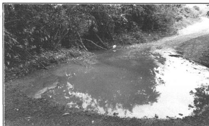
FOTO 5 - LOCAL DA CONSTRUÇÃO-BUEIRO
