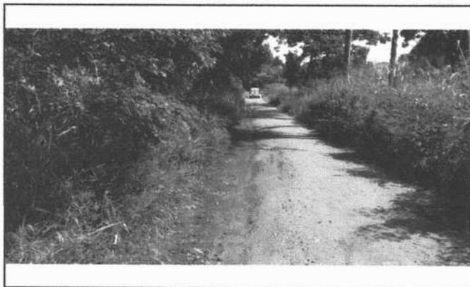
FOTO 3 - LOCALIZAÇÃO DO BUEIRO 02
