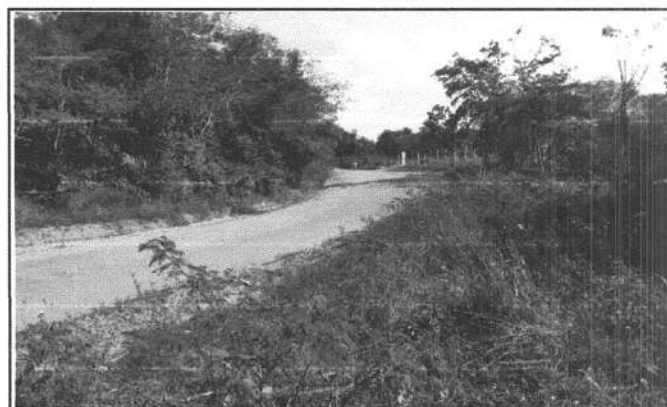
FOTO 4 - LOCAL DA CONSTRUÇÃO - BUEIRO
