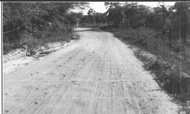
FOTO 8 - LOCAL DA CONSTRUÇÃO - BUEIRO
