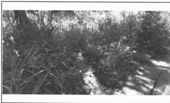
FOTO 5 - LOCALIZAÇÃO DO BUEIRO 02 - À JUSANTE
