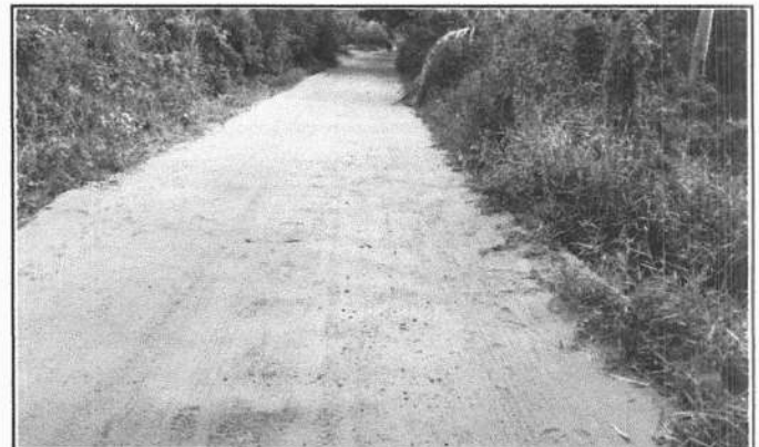
FOTO 4 - LOCAL DA CONSTRUÇÃO - BUEIRO
