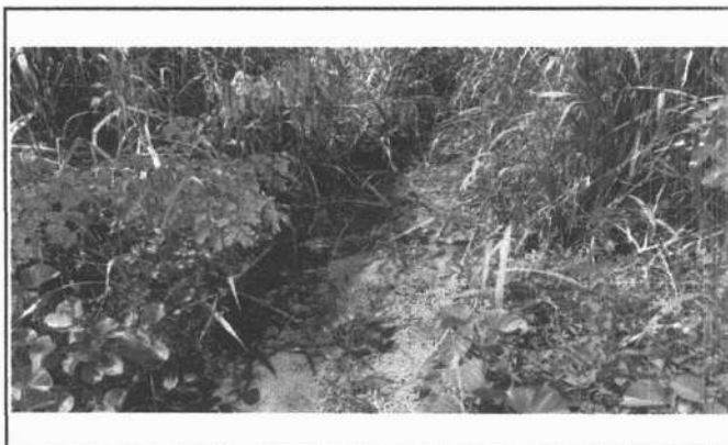
FOTO 2 - LOCALIZAÇÃO BUEIRO 01 - À JUSANTE
