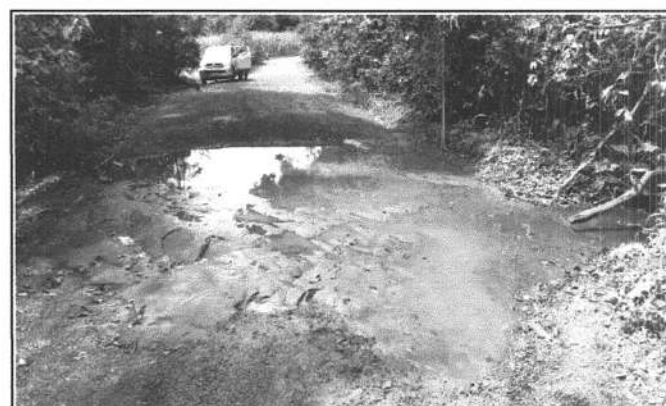
FOTO 6 - LOCAL DA CONSTRUÇÃO-BUEIRO
