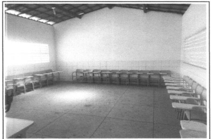
FOTO 12 - SALA DE AULA
