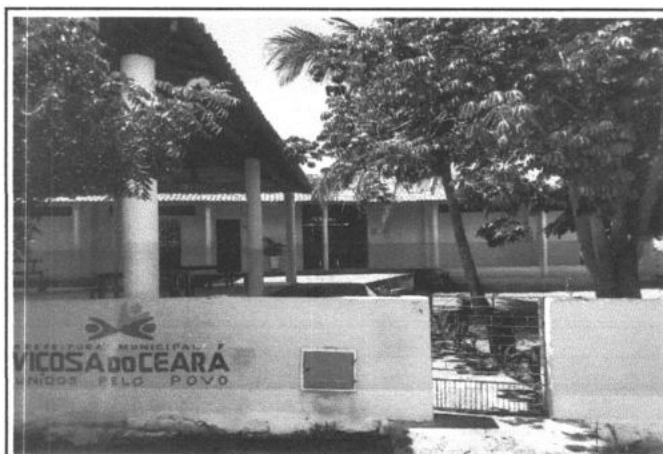
FOTO 2 - MURETA DE CONTORNO
