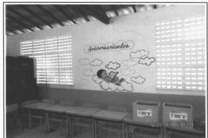
FOTO 18 - SALA DE AULA
