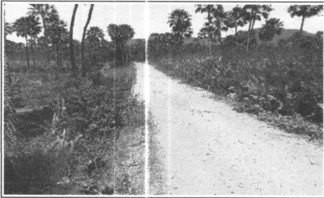
FOTO 3 - LOCAL DA OBRA
