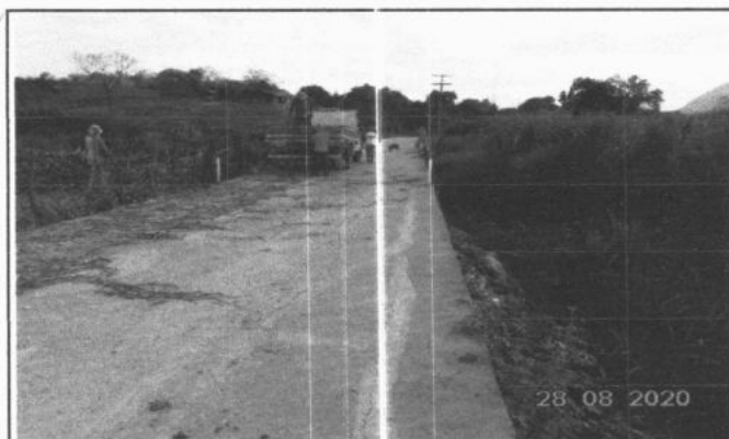
FOTO 5 - RECUPERAÇÃO DE PISO
