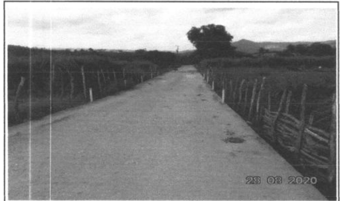
FOTO 2 - RECUPERAÇÃO DE PISO
