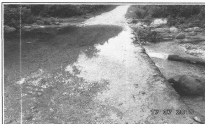
FOTO 4 - RECUPERAÇÃO DE PISO
