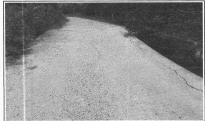
FOTO 6 - RECUPERAÇÃO DE PISO
