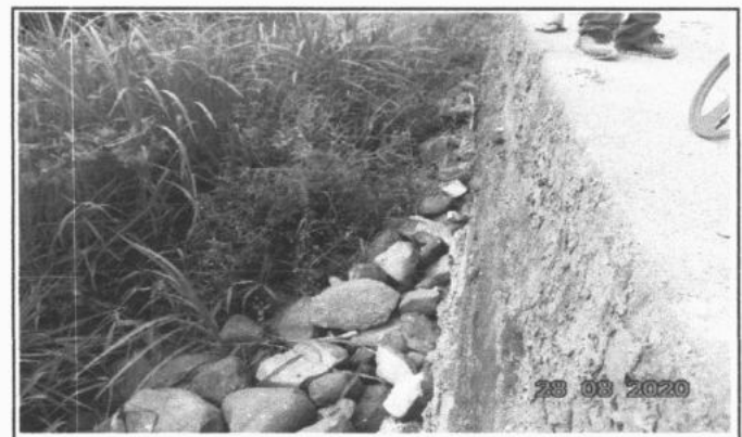
FOTO 4 - JUSANTE PASSAGEM MOLHADA
