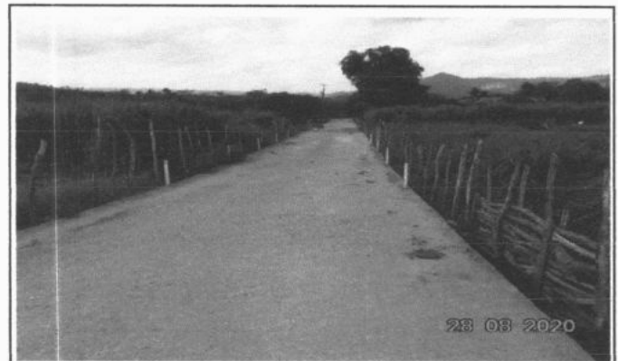
FOTO 2 - RECUPERAÇÃO DE PISO
