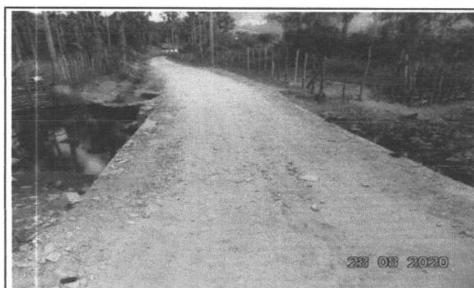
FOTO 6 - RECUPERAÇÃO DE PISO
