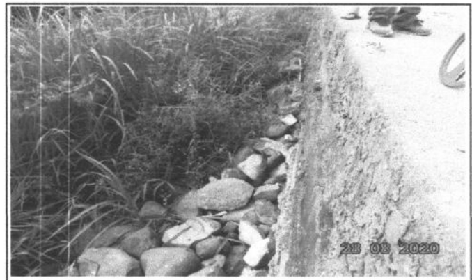
FOTO 4 - JUSANTE PASSAGEM MOLHADA
