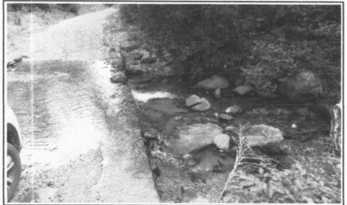
FOTO 2 - RECUPERAÇÃO DE PISO
