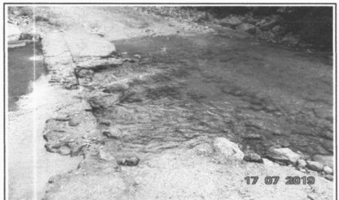
FOTO 6 - RECUPERAÇÃO DE PISO
