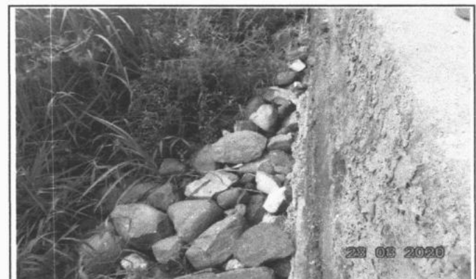
FOTO 6 - JUSANTE PASSAGEM MOLHADA
