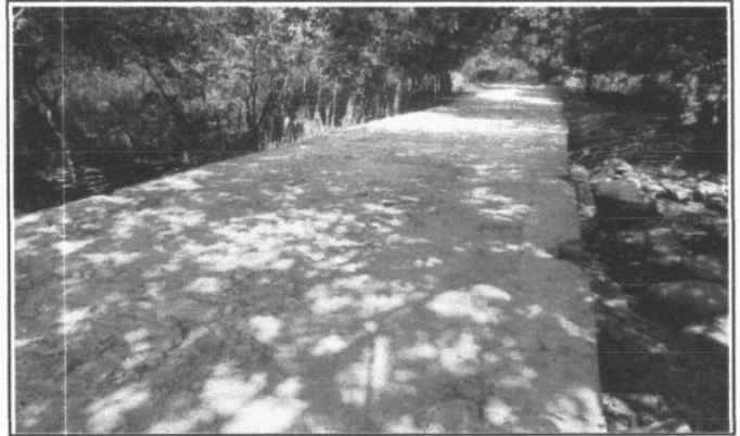
FOTO 2 - RECUPERAÇÃO DE PISO
