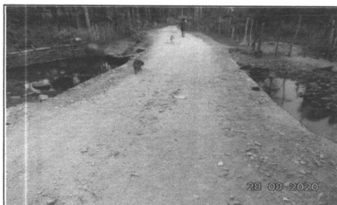
FOTO 2 - RECUPERAÇÃO DE PISO
