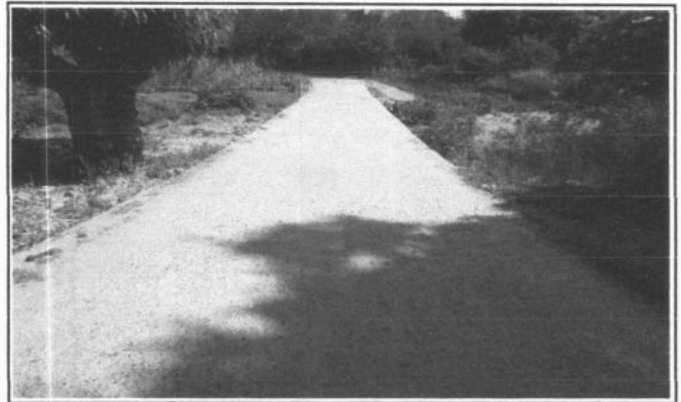
FOTO 2 - INSTALAÇÃO DE BALIZADORES
