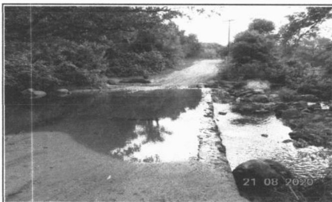
FOTO 2 - RECUPERAÇÃO DE PISO
