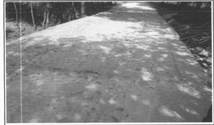
FOTO 6 - RECUPERAÇÃO DE PISO
