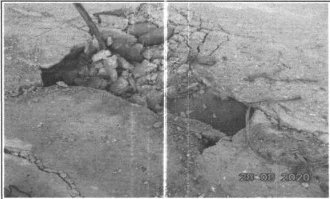
FOTO 1 - RECUPERAÇÃO DE PISO
