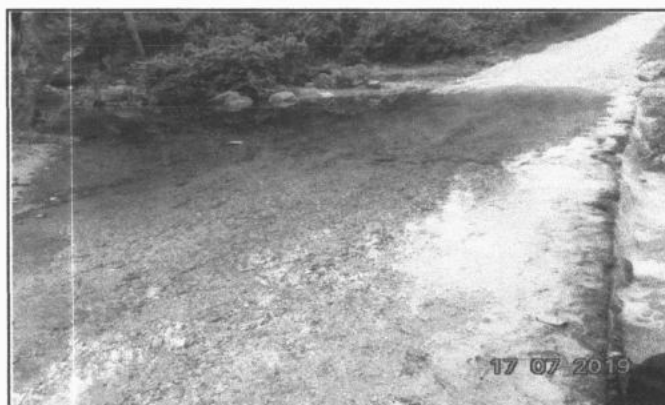
FOTO 6 - RECUPERAÇÃO DE PISO
