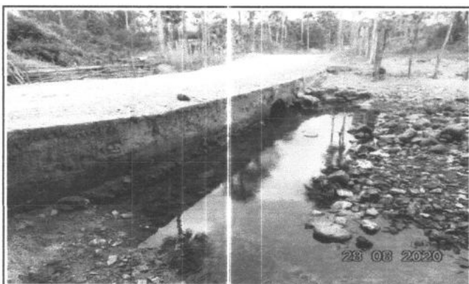
FOTO 5 - JUSANTE PASSAGEM MOLHADA
