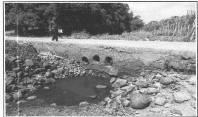
FOTO 6 - VISTA LATERAL PASSAGEM MOLHADA
