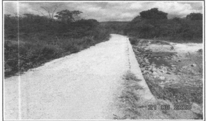
FOTO 2 - RECUPERAÇÃO DE PISO
