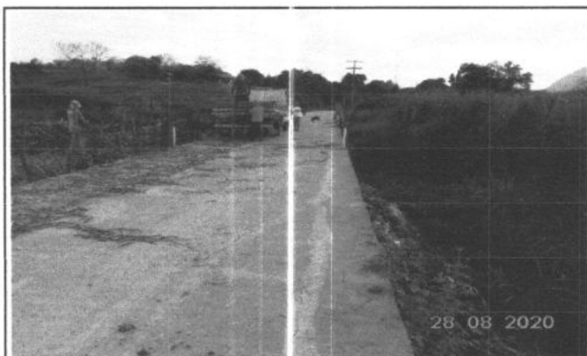
FOTO 5 - RECUPERAÇÃO DE PISO
