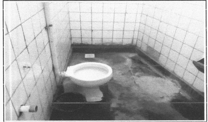
FOTO 4 - RECUPERAÇÃO DE INSTALAÇÕES HIDROSANITÁRIAS
