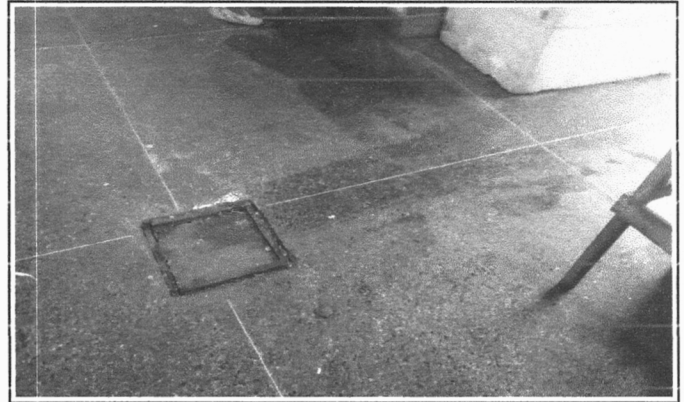
FOTO 8 - RECUPERAÇÃO DE PISOS INTERNOS
