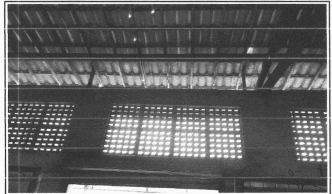
FOTO 10 - RECUPERAÇÃO DE COBERTA
