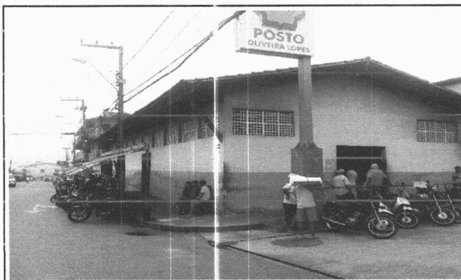
FOTO 11 - SERVIÇOS DE PINTURA EM GERAL
