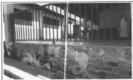
FOTO 7 - REDEÇOS DETERIORADOS
