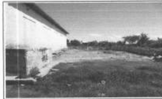
FOTO 6 - LOCAL DA CONSTRUÇÃO/AMPLIAÇÃO
