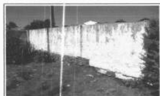
FOTO 15 - REFORÇO ESTRUTURAL NA FACHADA DO MURO DE CONTOURNO
