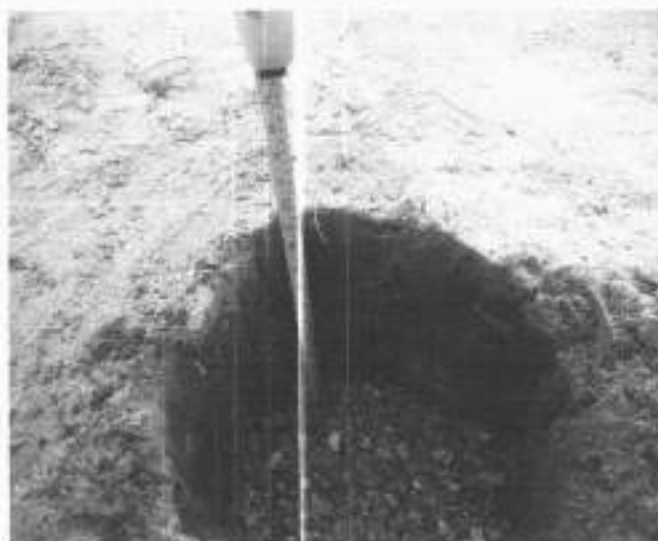
Preenchimento com 10cm de brita
