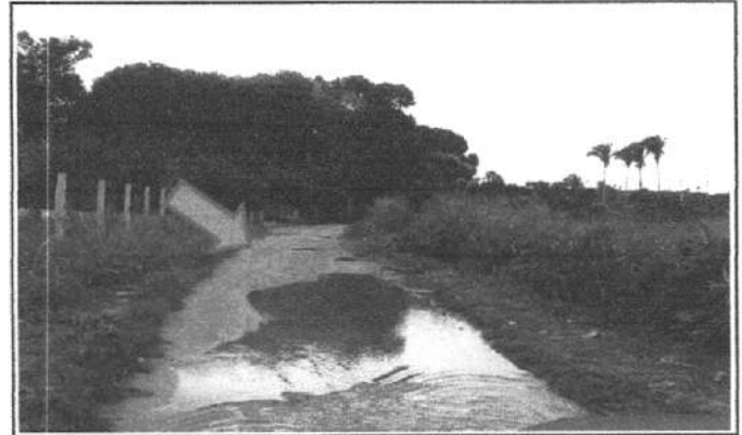
FOTO 16 - Trecho: Rua S.D.O. 02 - Vila Santo Expedito (novo bueiro)
