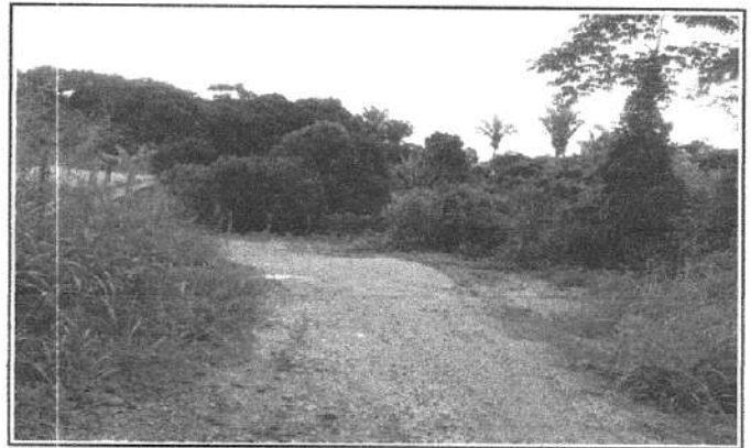
FOTO 2 - Trecho: Rua S.D.O. 01 - Sítio Barra
