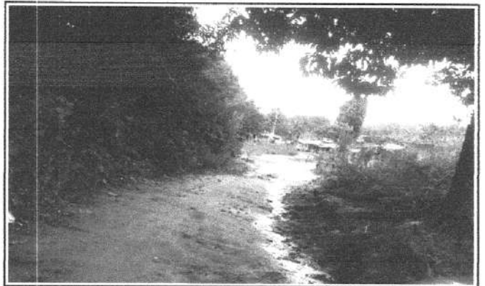
FOTO 4 - Trecho: Rua S.D.O. 01 - Sítio Barra
