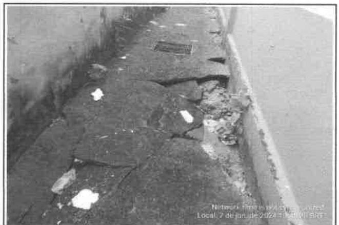
FOTO 18 - DEMOLIÇÃO E RECUPERAÇÃO DE PISO CIMENTADO CONTORNO BLOCO ANEXO
