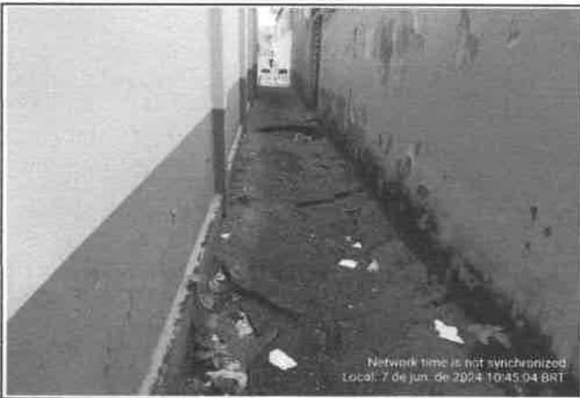
FOTO 15 - DEMOLIÇÃO E RECUPERAÇÃO DE PISO CIMENTADO CONTORNO BLOCO ANEXO
