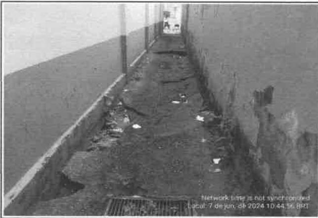
FOTO 13 - DEMOLIÇÃO E RECUPERAÇÃO DE PISO CIMENTADO
