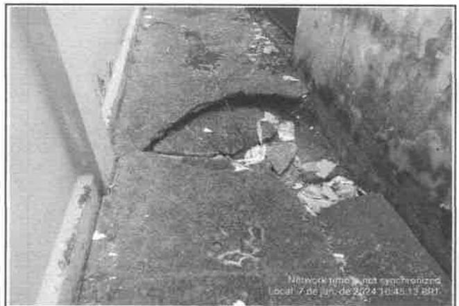
FOTO 16 - DEMOLIÇÃO E RECUPERAÇÃO DE PISO CIMENTADO CONTORNO BLOCO ANEXO
