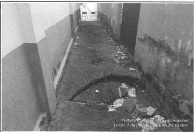
FOTO 17 - DEMOLIÇÃO E RECUPERAÇÃO DE PISO CIMENTADO CONTORNO BLOCO ANEXO
