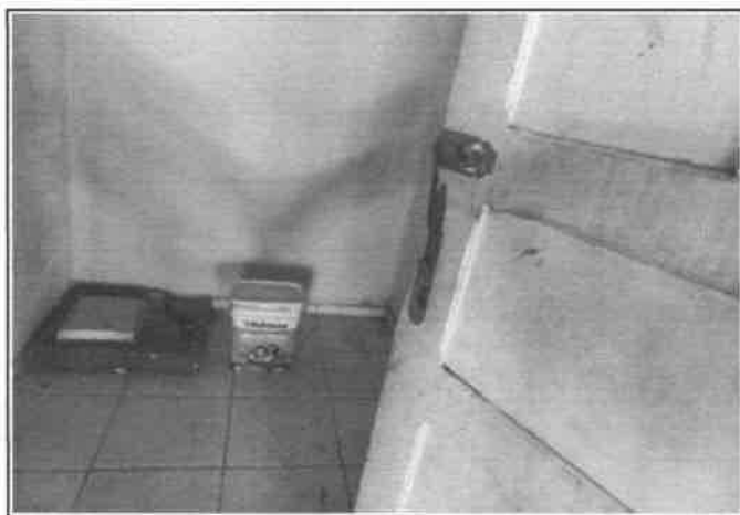
FOTO 21 - SUBSTITUIÇÃO DE PORTAS
