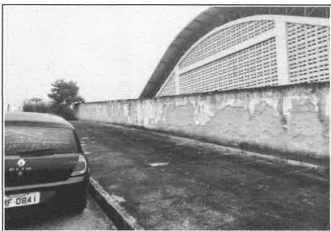
FOTO 1 - REVESTIMENTOS DETERIORADOS
