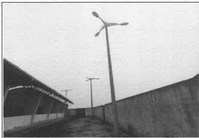
FOTO 9 - SUBSTITUIÇÃO DE LUMINÁRIAS
