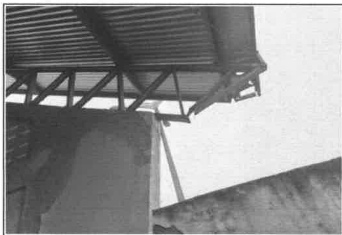
FOTO 17 - REPARO DE ESTRUTURAS
