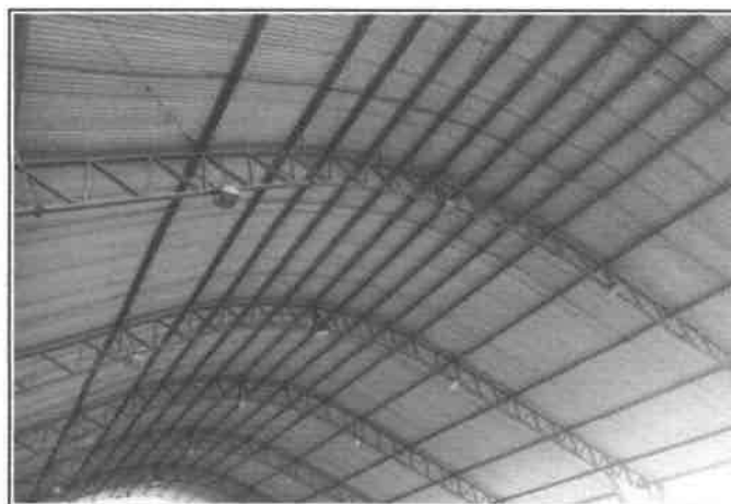
FOTO 18 - PINTURA DE ESTRUTURAS
