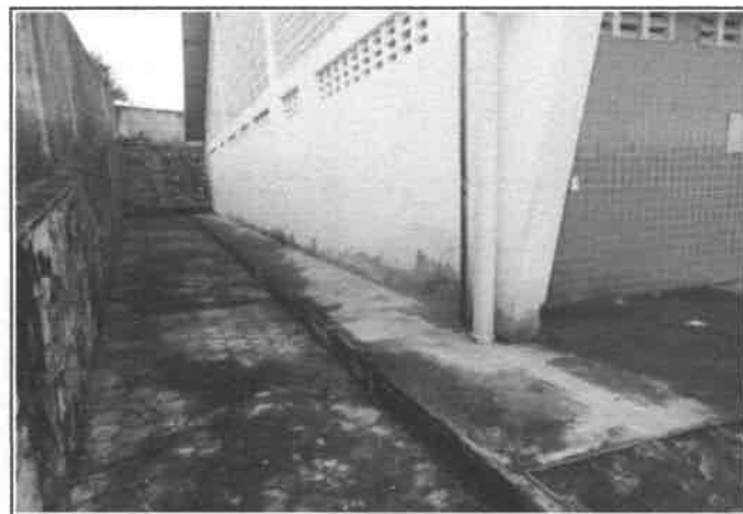
FOTO 10 - REVESTIMENTOS DETERIORADOS
