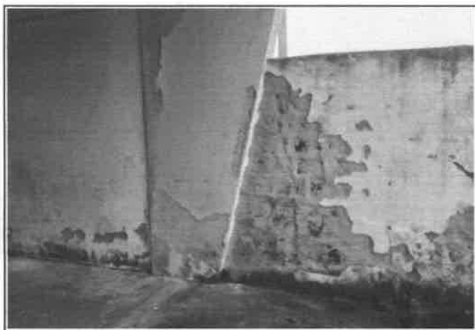
FOTO 13 - REVESTIMENTOS DETERIORADOS
