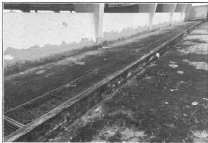
FOTO 11 - REVESTIMENTOS DETERIORADOS
