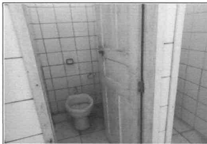
FOTO 22 - SUBSTITUIÇÃO DE LOUÇAS
