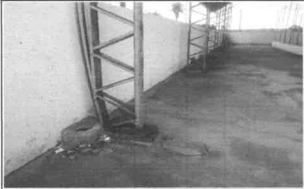
FOTO 19 - COLUNAS METÁLICAS TRELIÇADA
