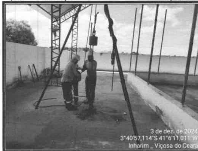
Foto 2 – Equipe nos preparativos para executar mais uma sondagem à percussão (SPT)
