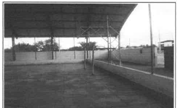
FOTO 18 - VISTA INTERNA MURETA DIVISÓRIA QUADRA
