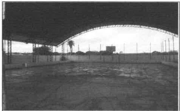
FOTO 10 - VISTA COBERTA E ESTRUTURA METÁLICA QUADRA
