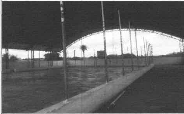
FOTO 13 - TUBOS DE AÇO ALAMBRADO
