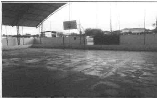
FOTO 17 - VISTA INTERNA ENTRADA QUADRA
