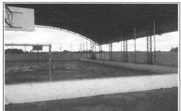
FOTO 6 - MURETA VISTA INTERNA QUADRA
