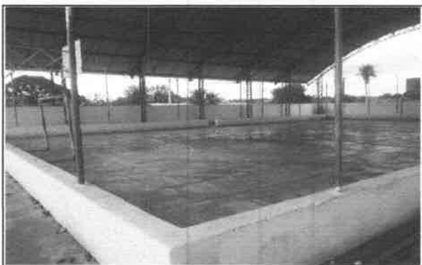
FOTO 11 - VISTA TUBOS DE AÇO ALAMBRADO
