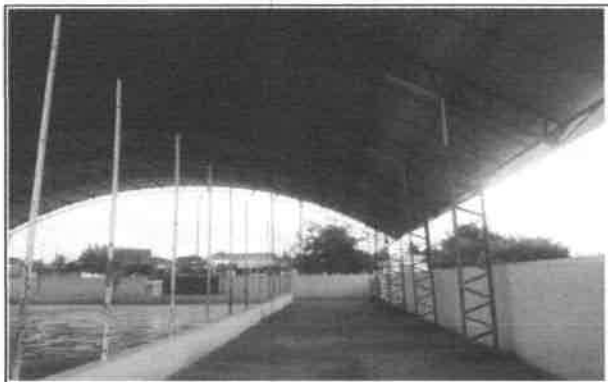
FOTO 23 - ESTRUTURA DE AÇO TRELIÇA DE COBERTA
