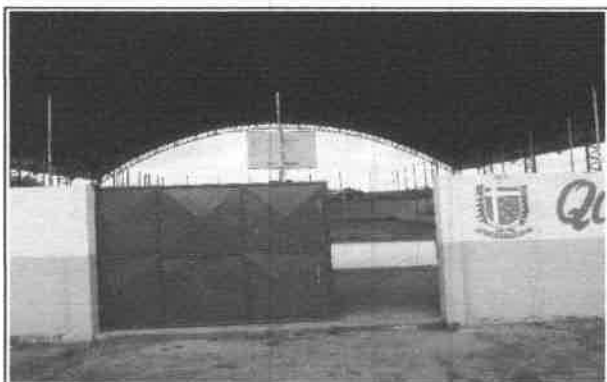
FOTO 5 - PORTÃO EM CHAPA DE AÇO ENTRADA
